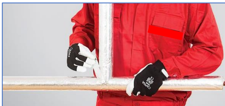
Pic. 4 centrum izolacji: insulating a T-fitting
