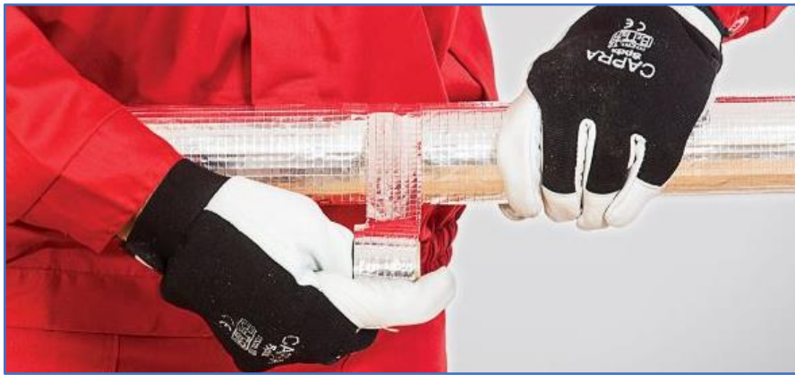
Pic. 1 centrum izolacji: securing segment joints
