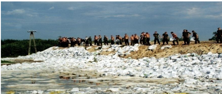
Fotografia nr 12.11. Zabezpieczanie wału workami z piaskiem (KCKR)
