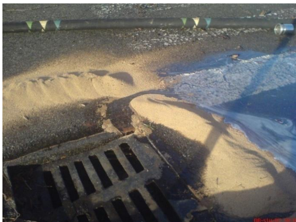
Fotografia nr 12.8. Zabezpieczenie studzienki sorbentem
