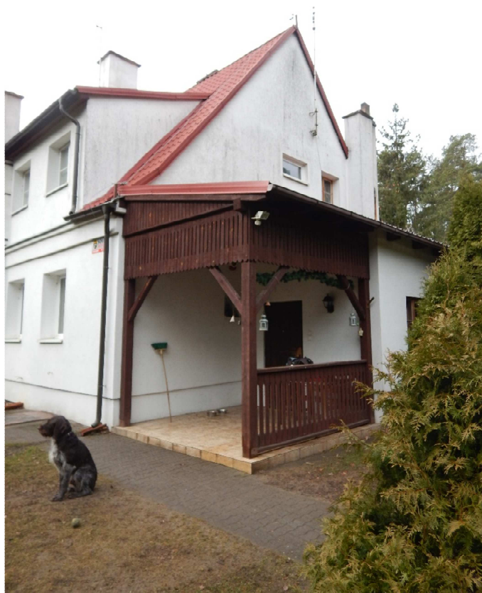
Fot. 4 Weranda przy wejściu do lokalu nr 1
