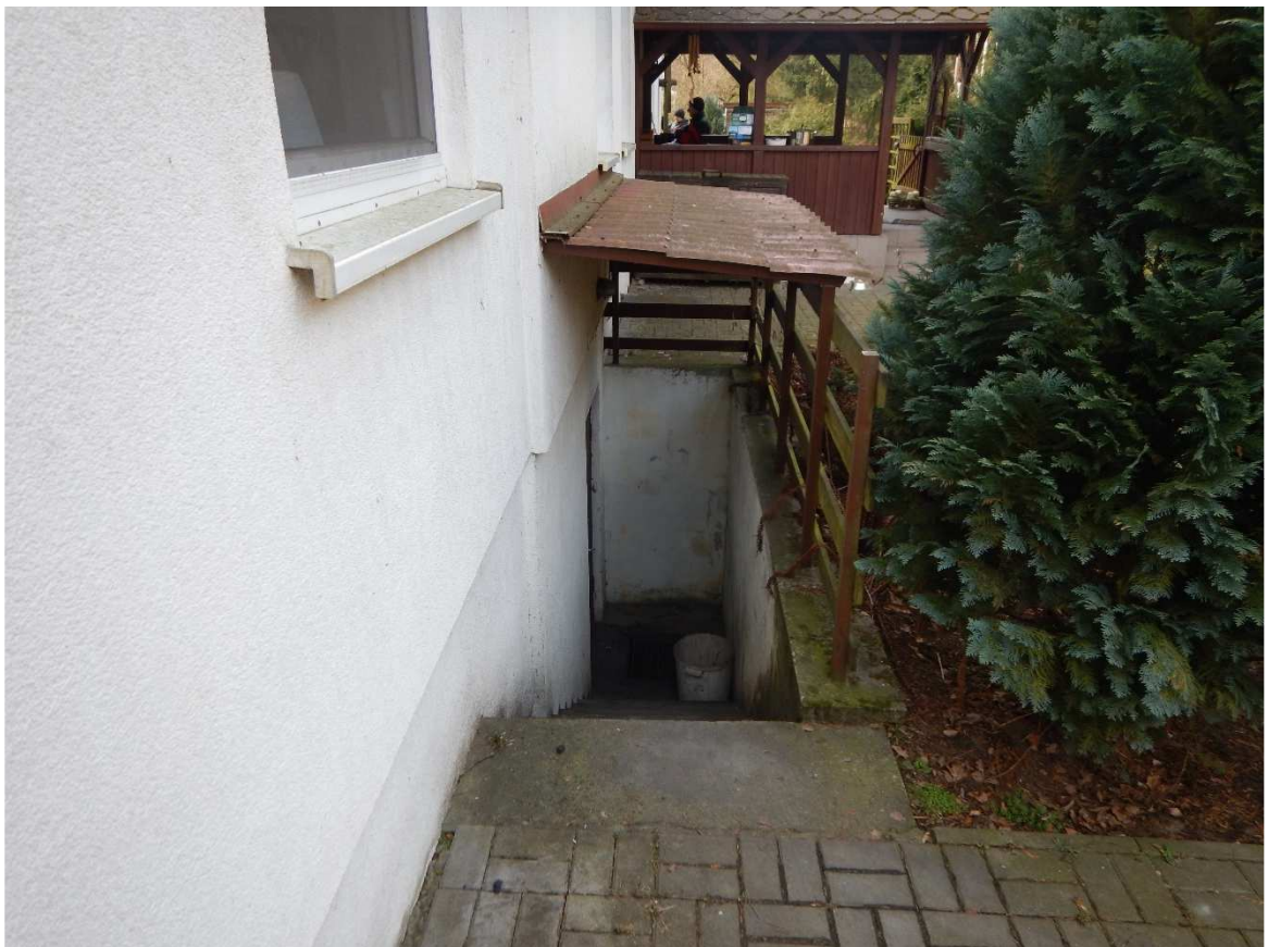
Fot. 10 Zejście do kottowni lokalu nr 2
