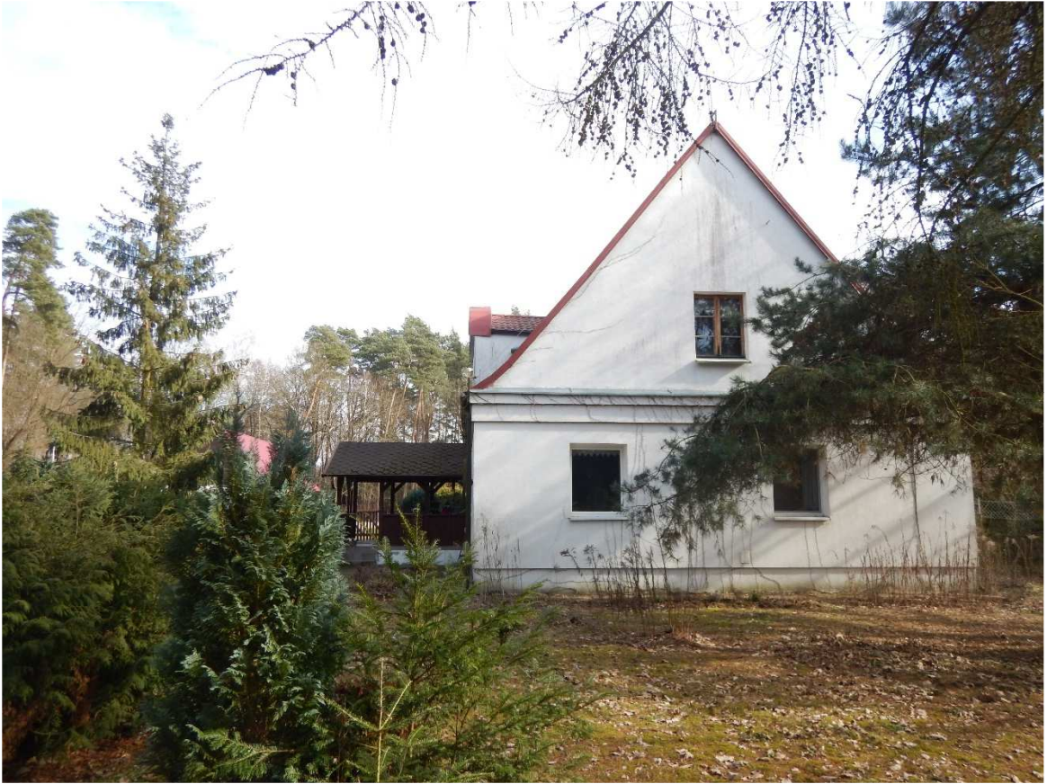
Fot. 7 Elewacja południowo-zachodnia
