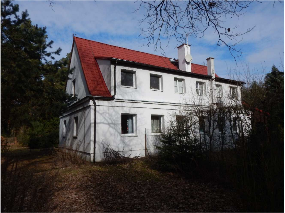
Fot. 5 Elewacja południowo-wschodnia
