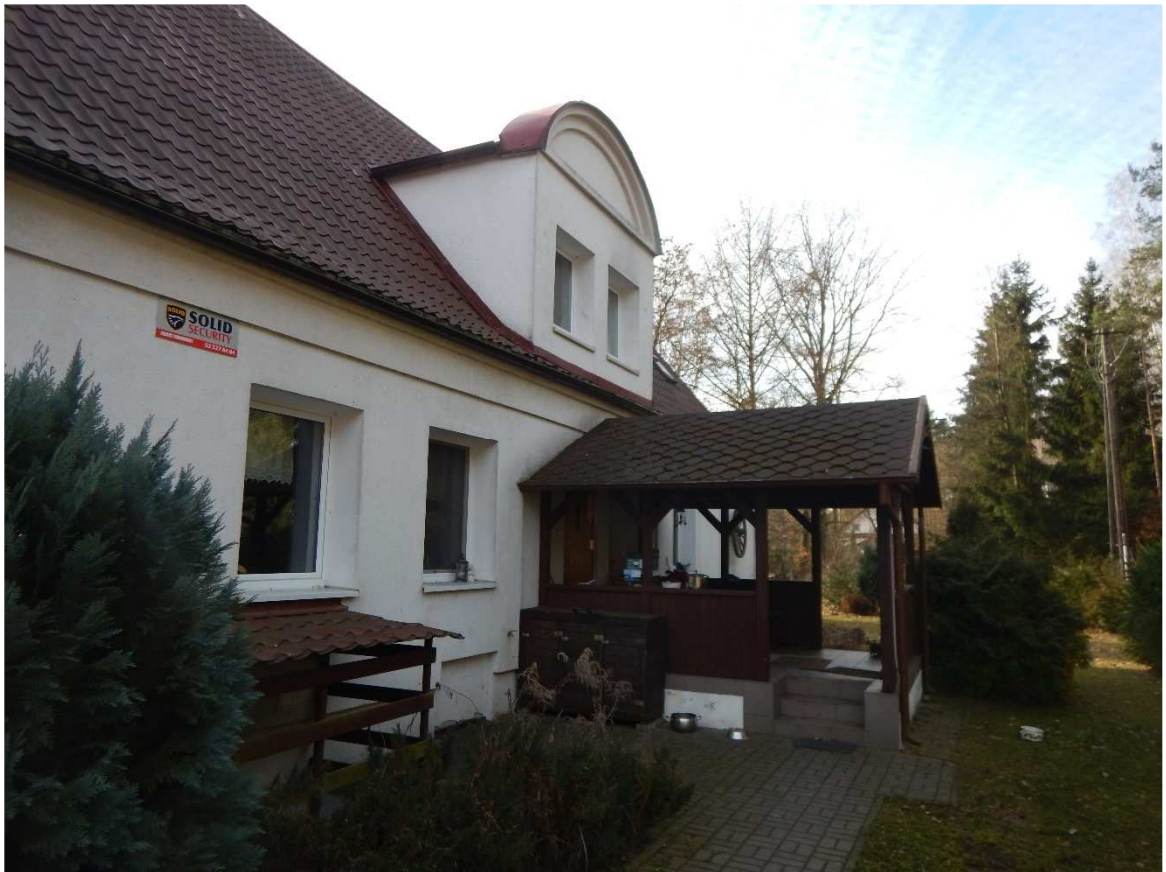
Fot. 9 Weranda przy wejściu do lokalu nr 2
