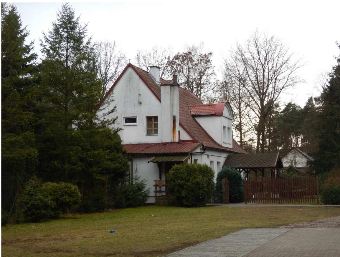
Fot. 3 Elewacja północno-wschodnia
