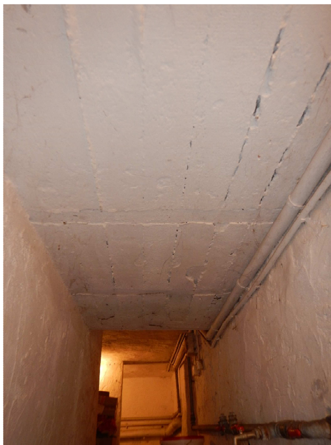
Fot. 13 Strop Kleina nad piwnicą
