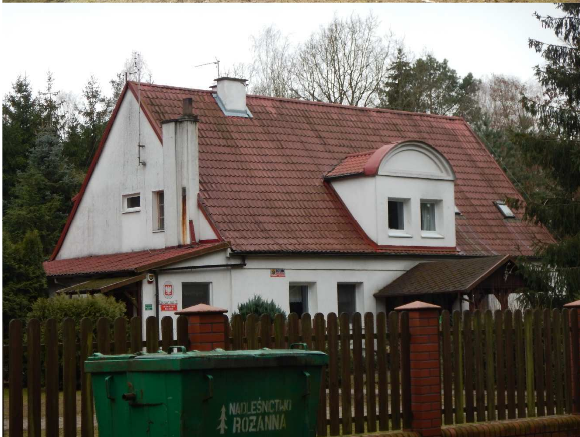
Fot. 1-2 Elewacja północno-zachodnia
