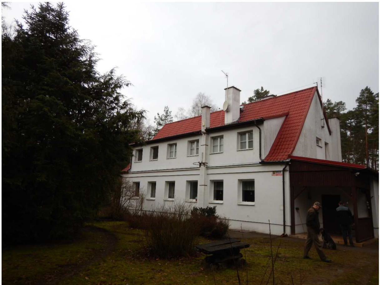
Fot. 6 Elewacja południowo-wschodnia
