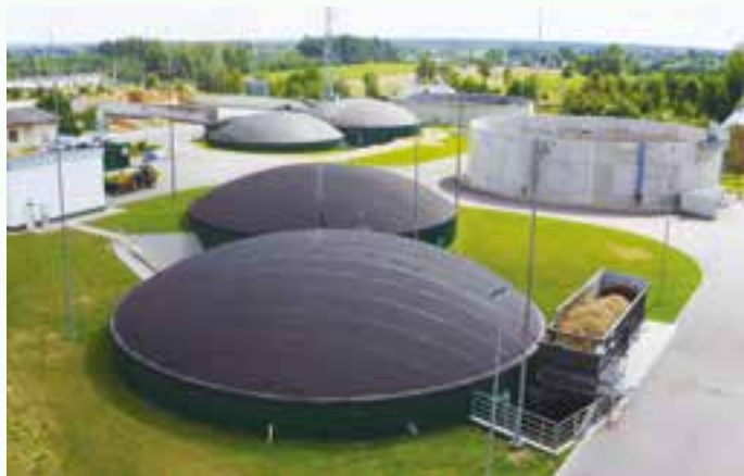
Biogazownia rolnicza w Michałowie
