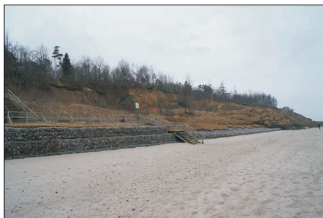
Fig. 2.18. Jastrzębia Góra, osuwisko w zabezpieczonym klifie, październik 2011 r.
