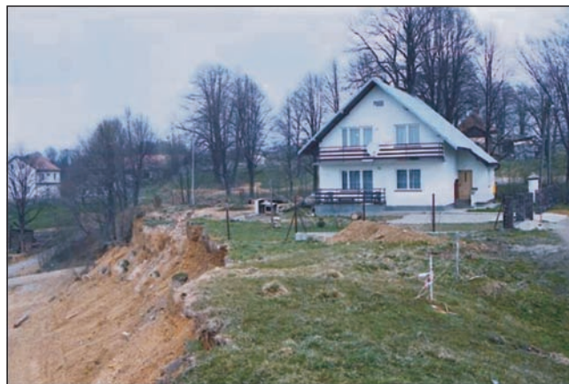
Fig. 2.4. Osuwisko Falkowa w Nowym Sączu
