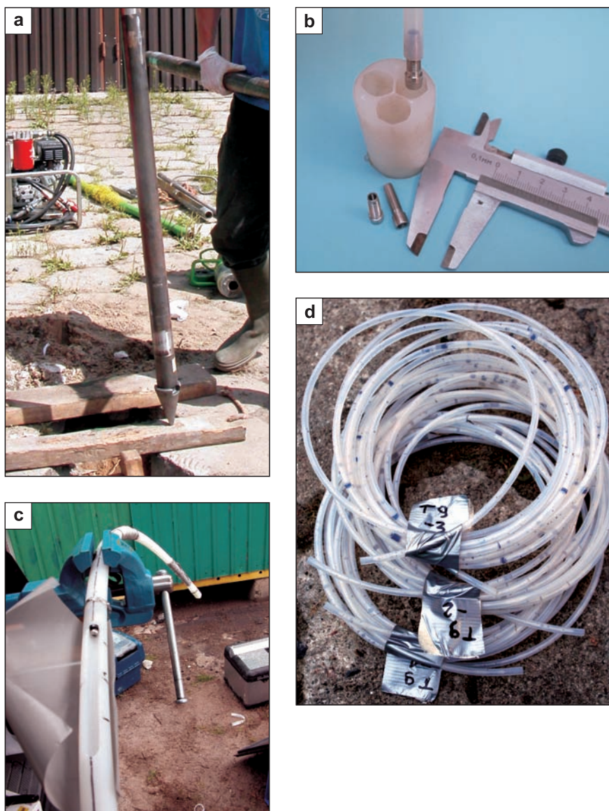
Fig. 7.8. a – Rura osłonowa zakończona stożkiem gubionym; b – 3-kanalowa rura CMT z polietylenu ma całkowitą średnicę zewnętrzną 28 mm, zaś opróbowanie w każdym otworze może być dokonywane za pomocą specjalnej minipompy napędzanej gazem lub zwyczajnej rurki teflonowej z wkręconym zaworkiem kulowym; c – Przygotowanie 3-kanalowej rury CMT w terenie; do wykonania stref filtrowych wykorzystuje się niewielkie arkusze siatki ze stali nierdzewnej, którymi owijane są nacięcia wybranego kanału; d – Rurki z twardego PE przypisane do kolejnych otworów w piezometrze T9 – jednym z wielu wykonanych przy użyciu 3-kanalowych rur CMT; Stara Gazownia, Bydgoszcz, 2007
