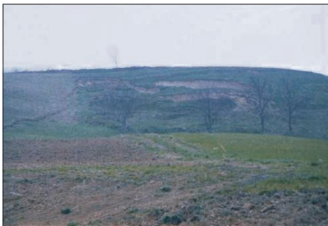
Fig. 2.3. Osuwisko koło Siennej nad Jezioro Rożnowskim
