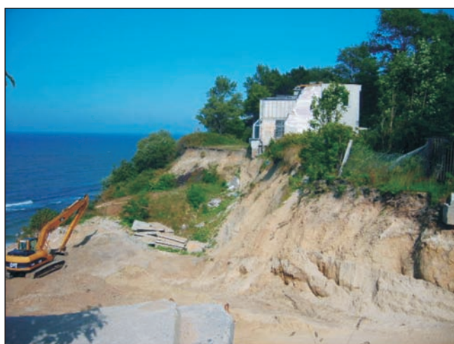
Fig. 2.16. Jastrzębia Góra, stabilizacja osuwiska w klifie
