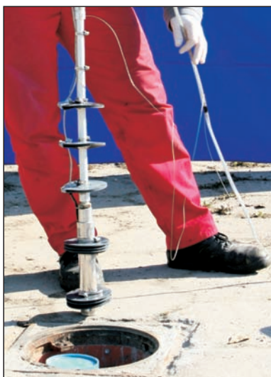
Fig. 7.5. Wirnikowa pompa zanurzeniowa MP-1 Grundfoss z kołnierzowym pakerem podwójnym, dostosowanym do otworu badawczego 5 cali
