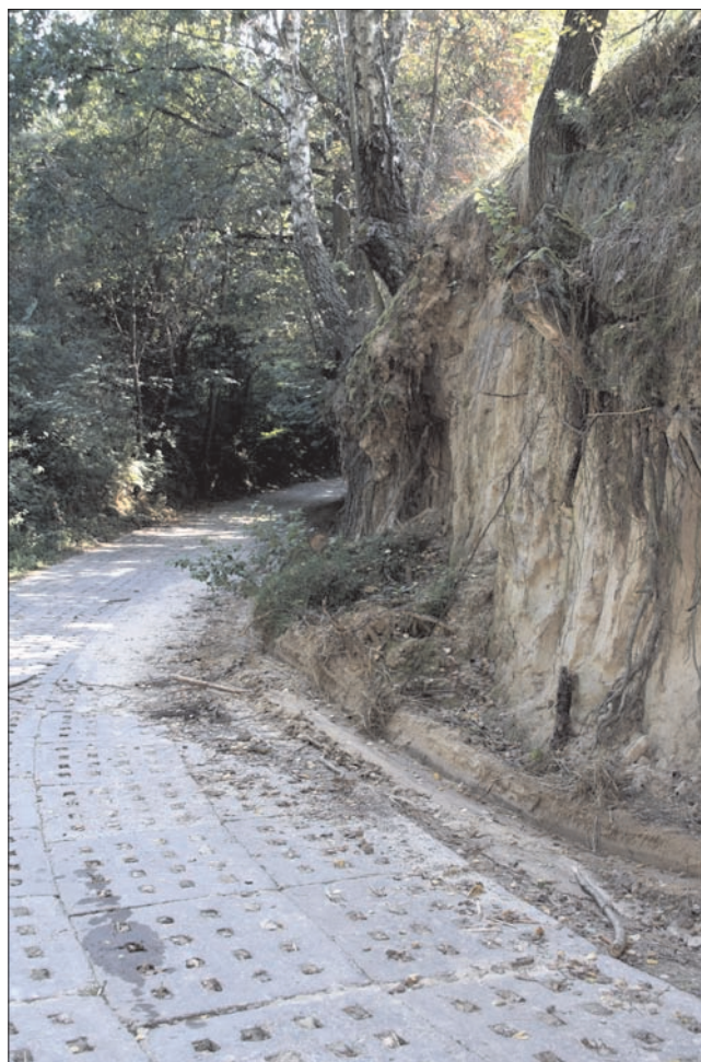
Fig. 16.23. Zabezpieczenie dna wąwozu płytami betonowymi
