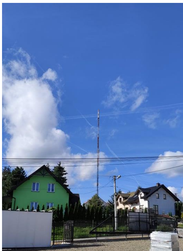
Rys. 3 Miejsce montażu SMS PEM – OSP Chorągwica – widok na RTCN Chorągwica
