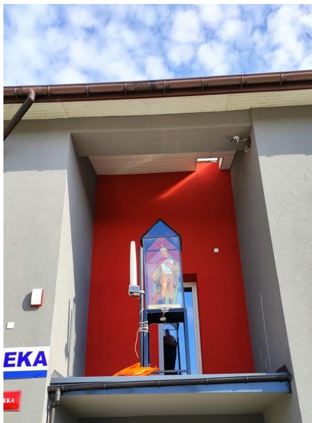
Rys. 2 Miejsce montażu SMS PEM – OSP Chorągwica
