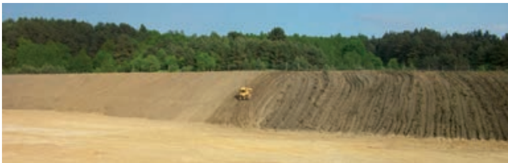
Formowanie skarpy nowej kwatery składowiska odpadów w Tczewie. Fot. ZUOS Tczew.
