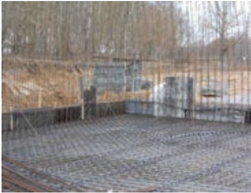
Budowa RZGO na wstępnym etapie. Fot. M. Sobczyk
