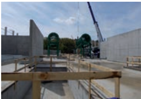
Ściany hali sortowni wraz z kanałami technologicznymi i sitami bębnowymi w tle. Fot. Mariusz Sobczyk
