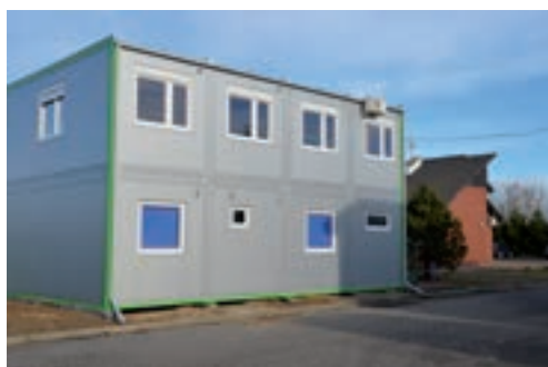
Budowa i montaż kontenerów socjalnych. Fot. D. Łęczyńska
