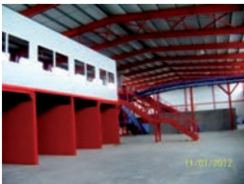
Kabina „trybuna” sortowniczej. Fot. ZUOK Stary Las
