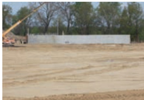
Prace zbrojeniowe i betonowe płyty fundamentowej biofiltra. Fot. Mariusz Sobczyk
