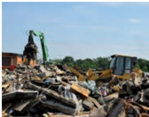
Składowisko w Lubsku - rozdrabnianie odpadów wielkogabarytowych. Fot. A. Stępska
