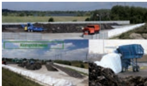
Kompostownia pryzmowa o wydajności 20 tys. Mg/rok i kompostownia w systemie CTI w rękawach foliowych o wydajności 13 tys. Mg/rok, uruchomiona w 2004 r. (zdj. z archiwum MZGOK-2004r.)
