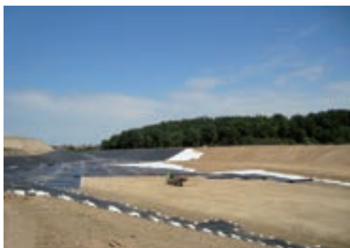
Budowa nowej kwatery składowiska odpadów w Tczewie. Fot. ZUOS Tczew.
