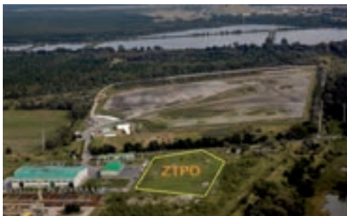
Dla kompleksowego zagospodarowania odpadów poza istniejącą sortownią, kompostownią i składowiskiem z systemem odzysku biogazu przetwarzanego na energię elektryczną brak jedynie ZTUOK pracującej w kogeneracji. (zdj. z archiwum MZGOK-2002r.)
