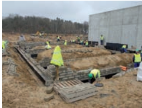
Przygotowanie fundamentów. Fot. M. Sobczyk
