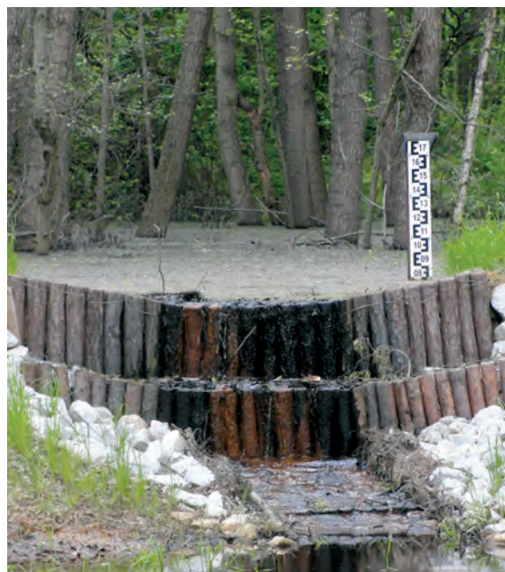
Fot. 56. Spowalnianie odpływu wody – zastawki na rowach drenujących (fot. zagan.zielonagora.lasy.gov.pl)
