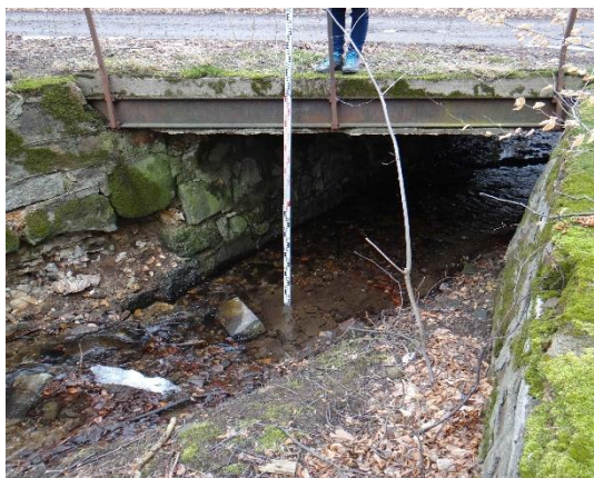
FOT. 3 WIDOK NA ISTNIEJĄCY MOST - WLOT
