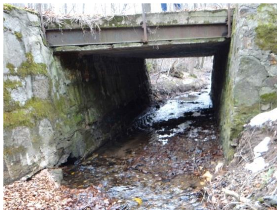
FOT. 4 WIDOK NA ISTNIEJĄCY MOST - WYLOT
