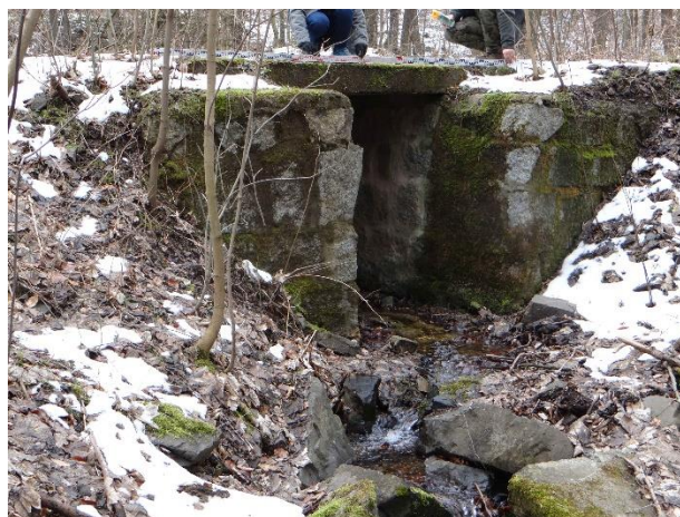
FOT. 2 WIDOK NA ISTNIEJĄCY MOST - WYLOT
