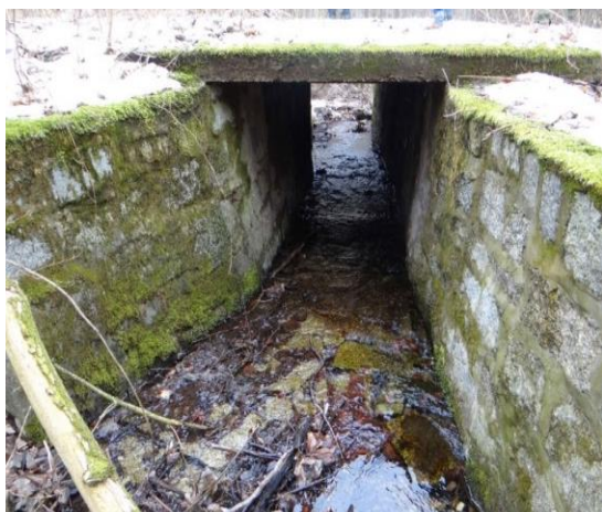
FOT. 1 WIDOK NA ISTNIEJĄCY MOST - WLOT
