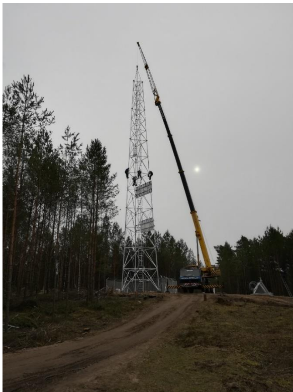
Wieża ppoż. w Leśnictwie Zacisze - budowa
