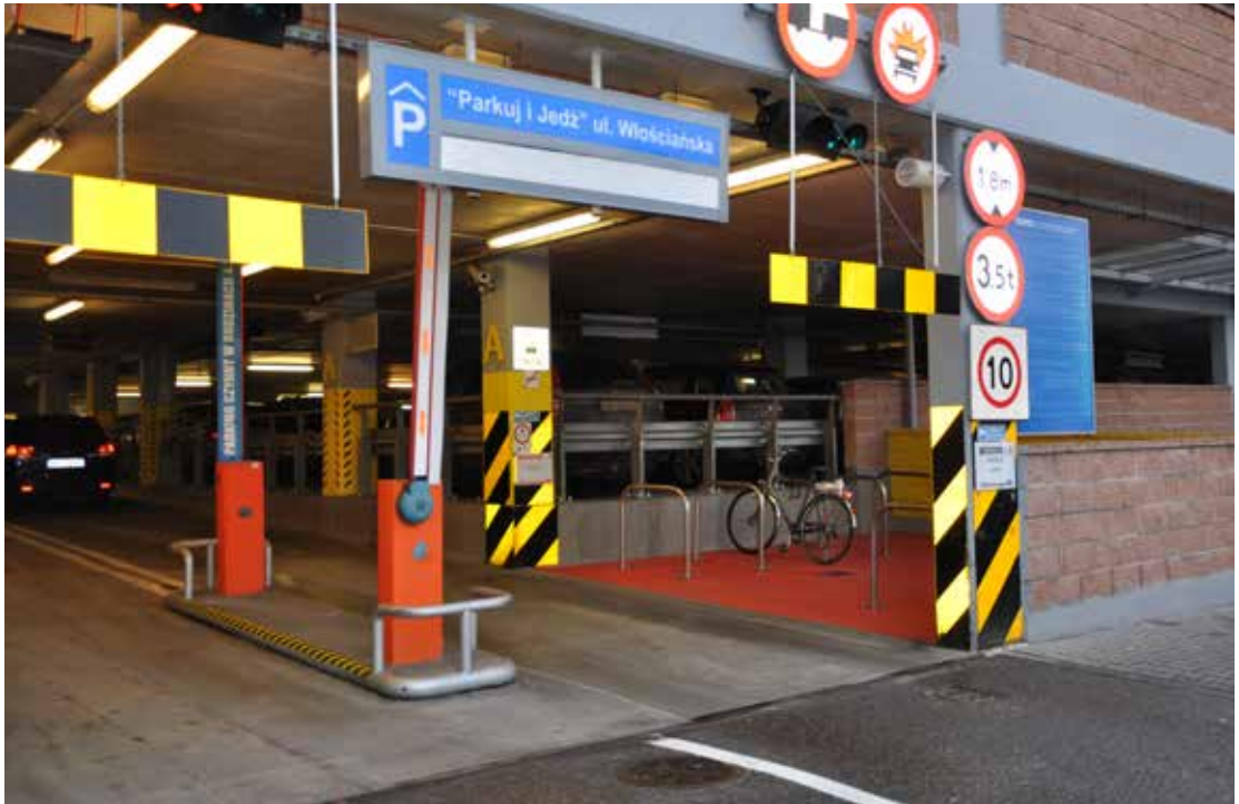
Fotografia 12. Przykładowe zdjęcie infrastruktury parkingowej dla rowerów w Warszawie – Parkuj i Jedź Metro Marymont Autor: J. Ogrodniczuk
