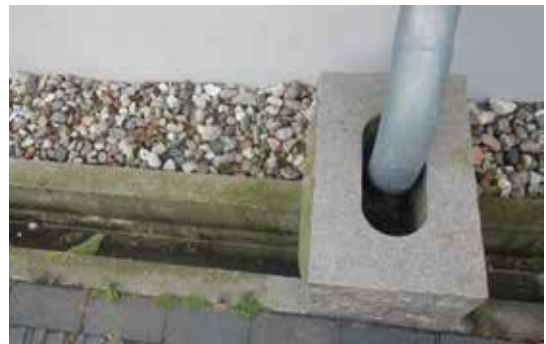
Fotografia 26. Sposób odprowadzenia wód otwartym kanałem – Malmö
