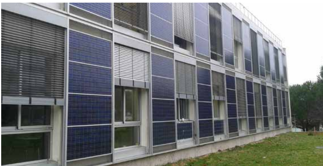
Fotografia 36. Przykład zintegrowanej fotowoltaiki na fasadzie budynku Autor: R. Wnuk
