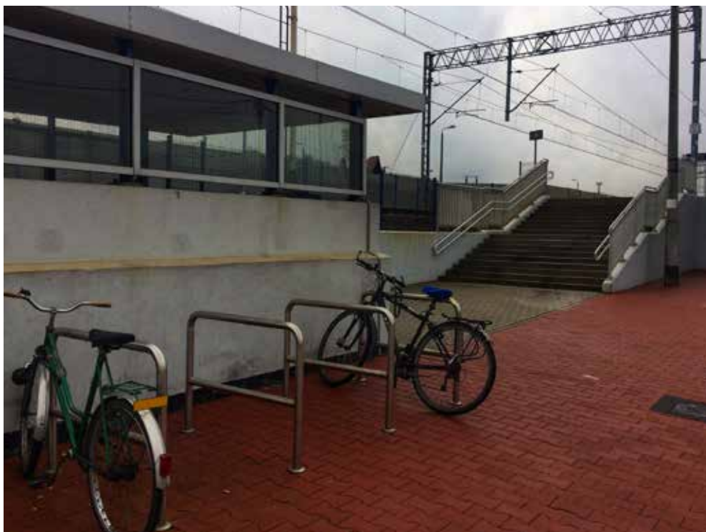
Fotografia 61. Parking dla rowerów znajdujący się przy stacji Staniątki Autor: A. Skrzypek
