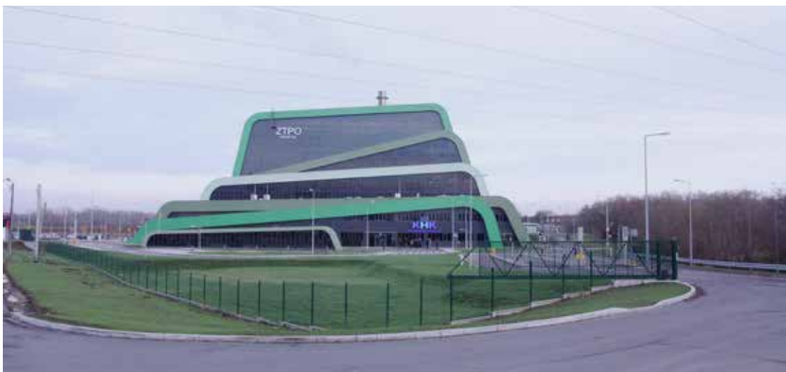
Fotografia 41. Widok Zakładu Termicznego Przekształcania Odpadów w Krakowie od frontu Autor: J. Wesółowska
