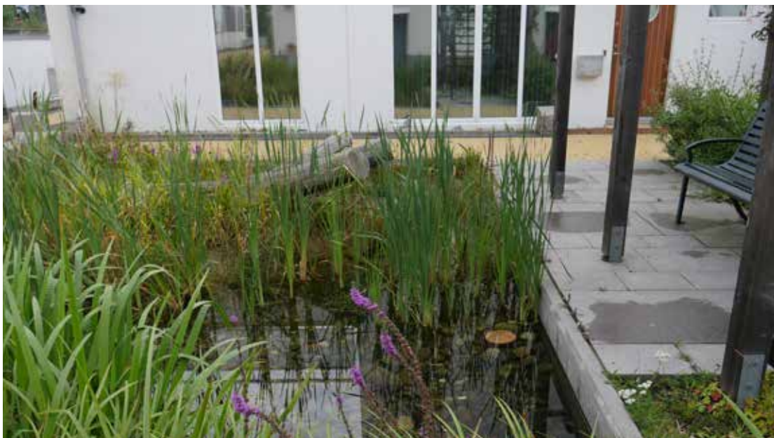
Fotografia 28. Sposób odprowadzenia wód otwartym kanałem – Malmö Autor: K. Solarek
