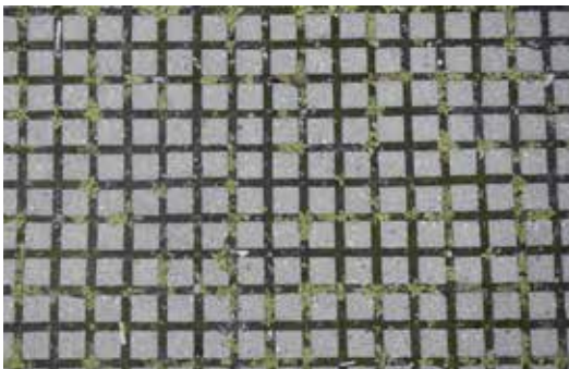
Fotografia 25. Nawierzchnia półprzepuszczalna – Malmö
