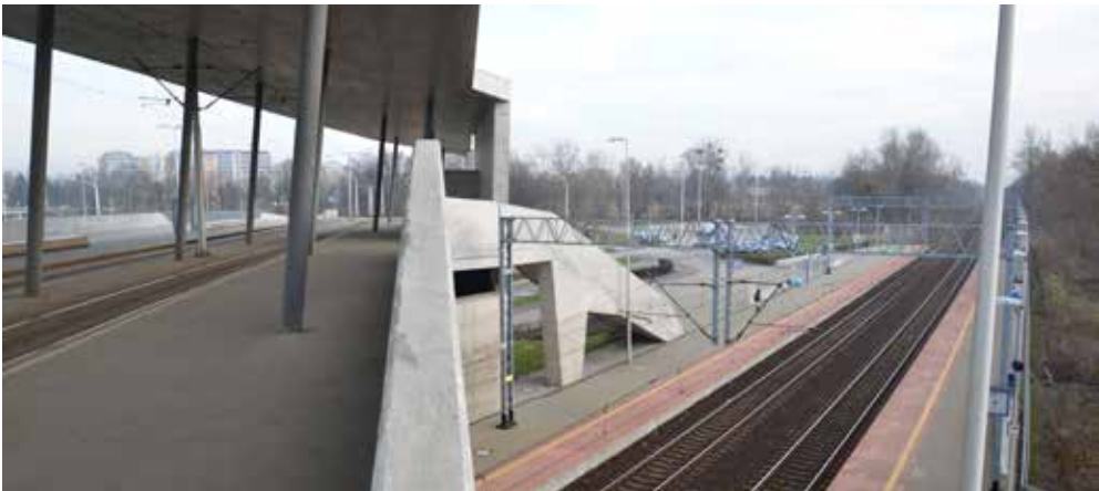
Fotografia 43. Zintegrowany Węzeł Przesiadkowy przy Stadionie Miejskim we Wrocławiu Autor: P. Wardęga
