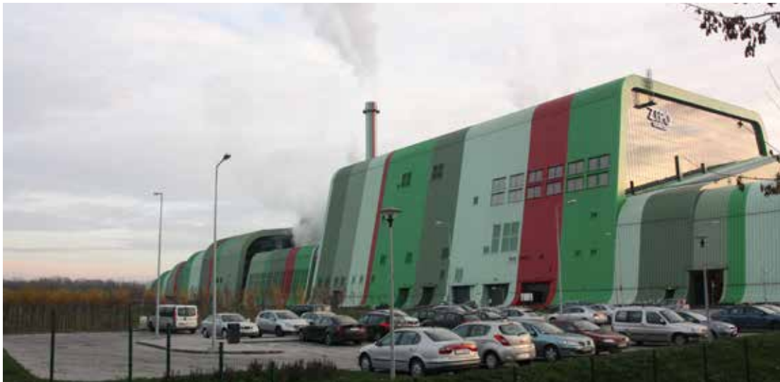
Fotografia 40. Widok Zakładu Termicznego Przekształcania Odpadów w Krakowie od strony północno-wschodniej elewacji Autor: J. Wesółowska
