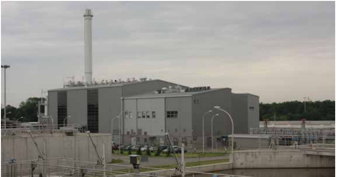
Fotografia 42. Stacja termicznej utylizacji osadów ściekowych na terenie oczyszczalni ścieków Czajka Autor: J. Wesółowska
