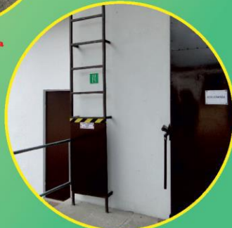
Ochrona przed wejściem na schody osób postronnych i dzieci.
