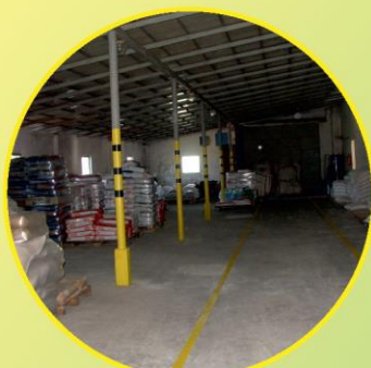
Wyznaczenie ciągów komunikacyjnych w pomieszczeniach gospodarskich.
