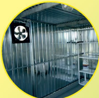
Wydzielone pomieszczenie z wentylacją i nieprzemakalną powierzchnią podłogi do przechowywania środków ochrony roślin.
