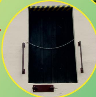
Zabezpieczenie otworów ściennych i zamontowanie zabezpieczeń drabina.
