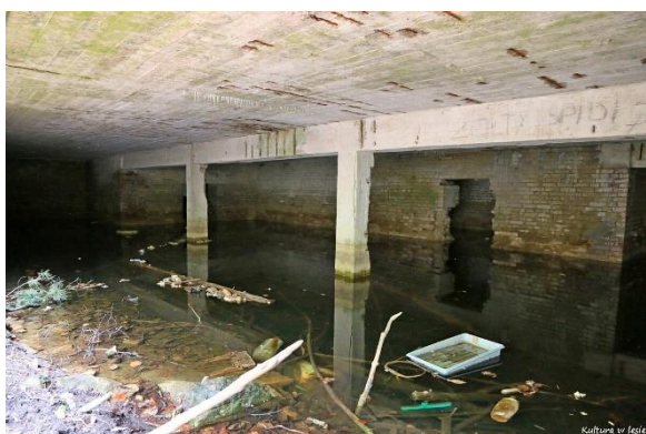
Fotografia 35 Ruiny obiektu przedwojennego lotniska „Fliegerhorst”, leśn. Bukowiec, oddział 634
