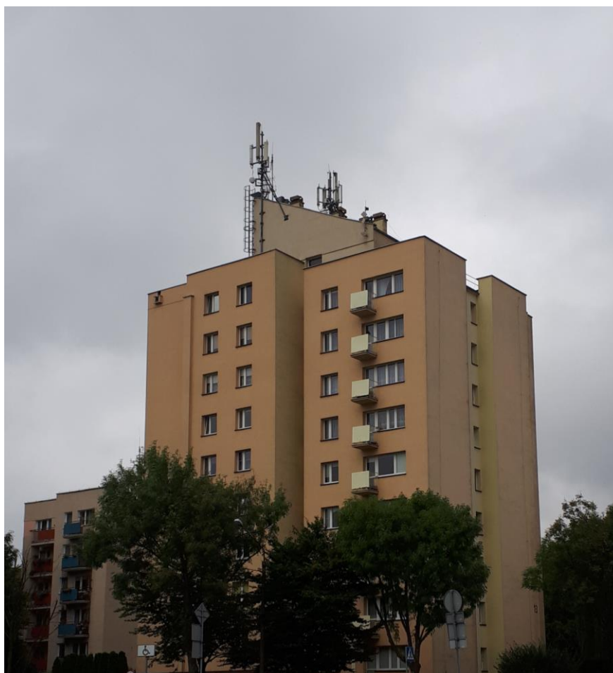
Fot. 1: Widok anten stacji bazowej ID: BT 24132, zlokalizowanej pod adresem: ul. Piotrkowska 13, 45-304 Opole
