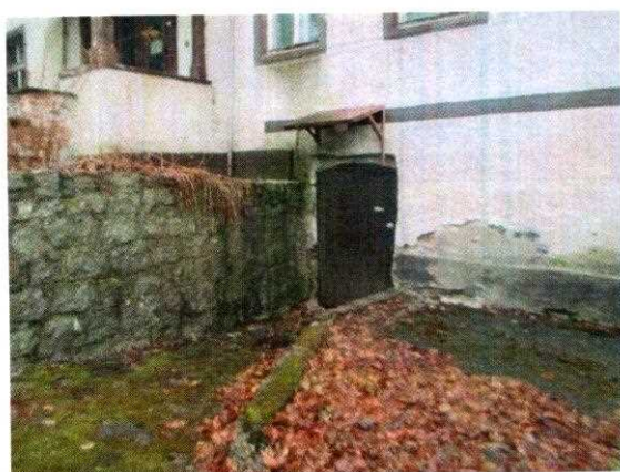
Wejście do piwnic
