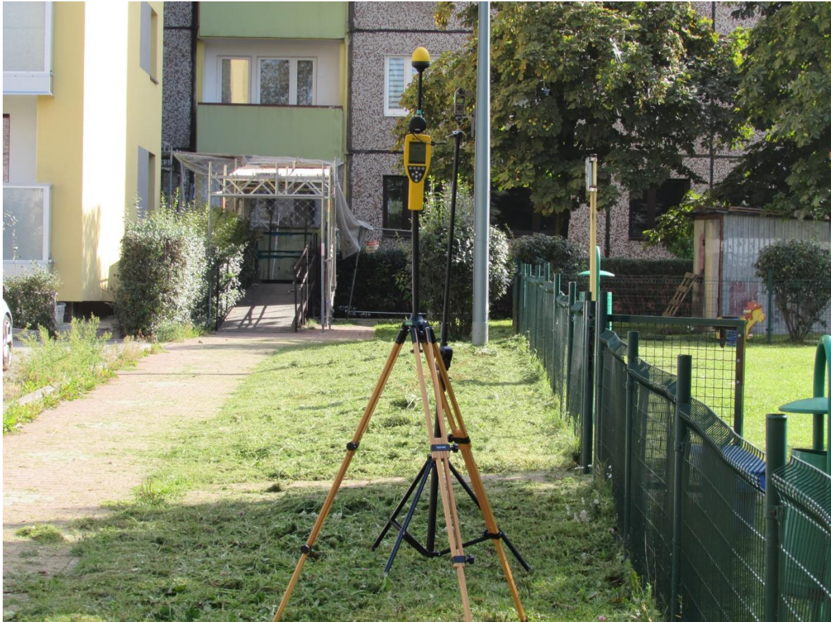
Fot. 2 Rejon badań, widok w kierunku wschodnim (E)
