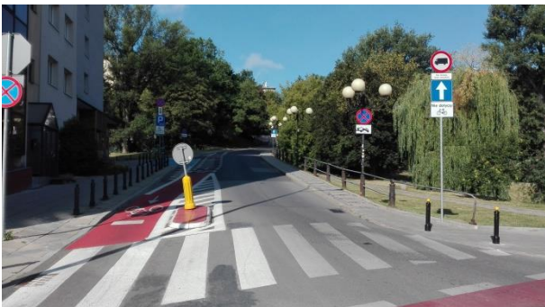
Fot. 6.17. Wlot kontrapasu na skrzyżowanie
