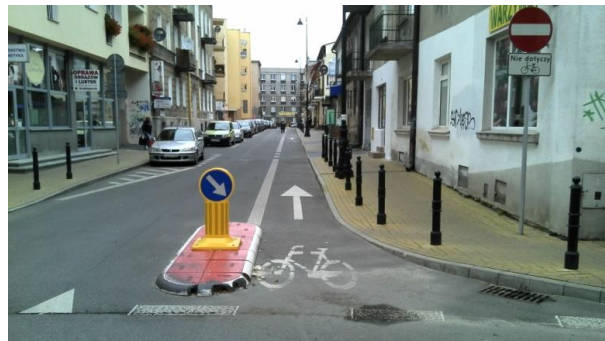
Fot. 6.18 Skrzyżowanie – wylot dla innych pojazdów stanowiący początek kontrapasu
