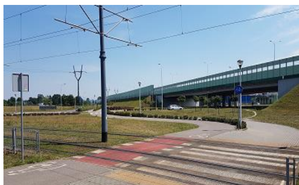
Fot. 6.32. Przejazd dla rowerzystów przez torowisko tramwajowe
