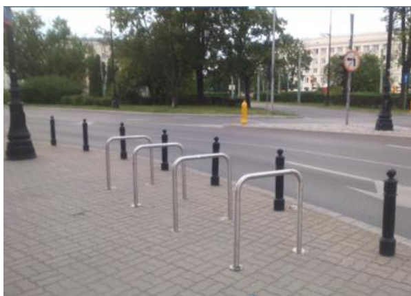
Fot. 6.48. Zalecane formy stojaków dla rowerów – strzemiona zapewniające możliwość ochrony ramy i koła roweru – parkowanie krótkookresowe
