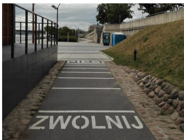
Fot. 6.25. Urządzenia uspokajające ruch rowerów
