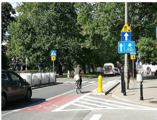
Fot. 6.10. Początek pasa ruchu dla rowerów
