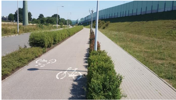
Fot. 6.3. Droga dla rowerów oddzielona od chodnika pasem zieleni
