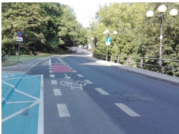
Fot. 6.9. Pas ruchu dla rowerów w kierunku przeciwnym (kontrapas)
