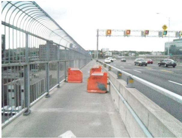
Fot. 6.29. „Szykany” na drodze dla rowerów na moście wymuszające ograniczenie prędkości
