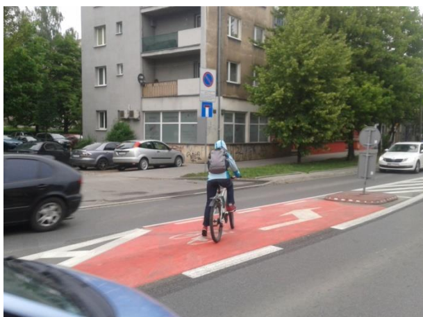
Fot. 6.19. Azyl dla rowerzysty skręcającego na skrzyżowaniu w lewo w kontrapas
