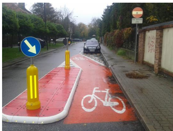
Fot. 6.12 Dwukierunkowy ruch dla rowerów na drodze jednokierunkowej (kontraruch) – wjazd
