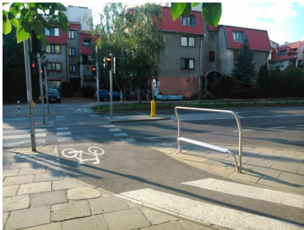
Fot. 6.45. Podpórki dla rowerzystów na wlocie na skrzyżowanie
