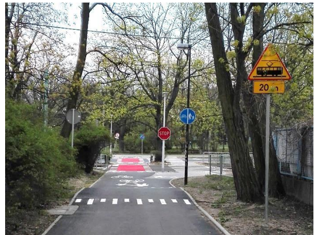
Fot. 6.30. Próg zwalniający na drodze dla rowerów
