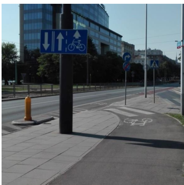
Fot. 6.21. Zjazd z drogi dla rowerów na pas ruchu dla rowerów
