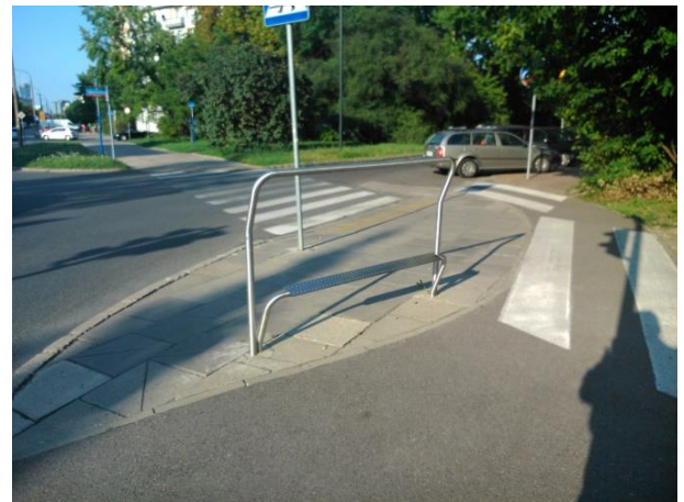
Fot. 6.46. Podpórki dla rowerzystów na wlocie na skrzyżowanie
