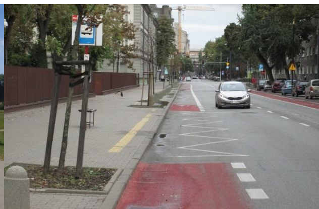
Fot. 6.24. Infrastruktura w rejonie przystanków komunikacji publicznej – pas ruchu dla rowerów z przerwą na przystanek autobusowy
