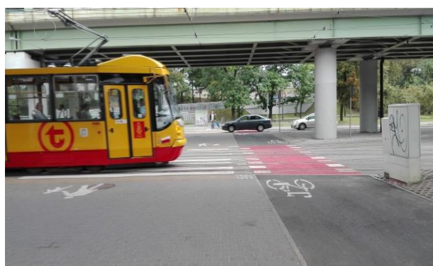
Fot. 6.31. Przejazd dla rowerzystów przez torowisko tramwajowe
