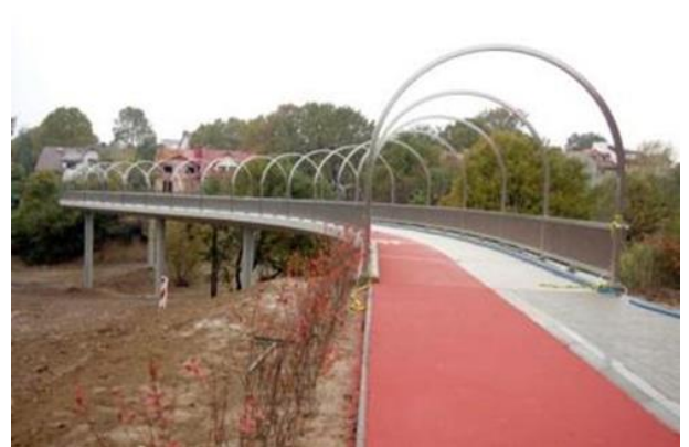
Fot. 6.41. Droga dla rowerów i droga dla pieszych na kładce
