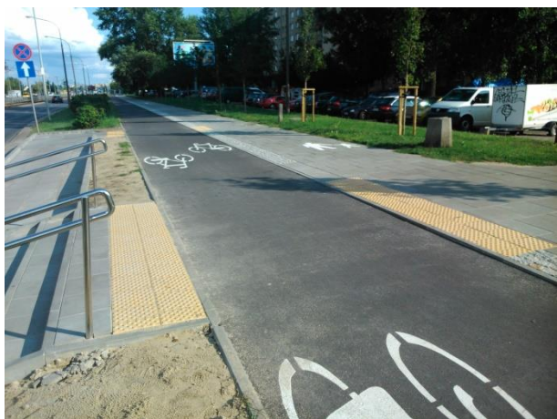
Fot. 6.33. Infrastruktura dla niepełnosprawnych – struktura nawierzchni przed drogą dla rowerów tzw. pola uwagi
