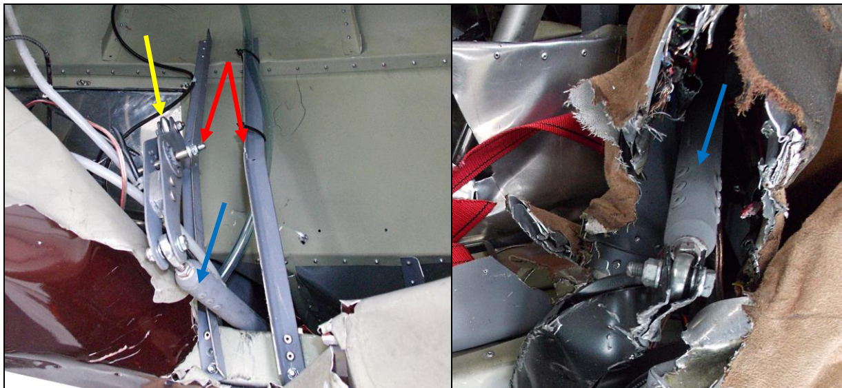
26, 27 – Popychacz sterowania sterem wysokości w kadłubie [niebieska strzałka], pokazany od strony tylnej części kadłuba i zniszczonego zawieszenia dźwigni pośredniej układu sterowania [strzałki czerwone] oraz od strony zniszczonej dźwigni na rurze skrętnej za dźwigarem centroplata w kadłubie. Żółtą strzałką wskazana urwana końcówka drugiego popychacza, oderwanego wraz z usterzeniem poziomym.
