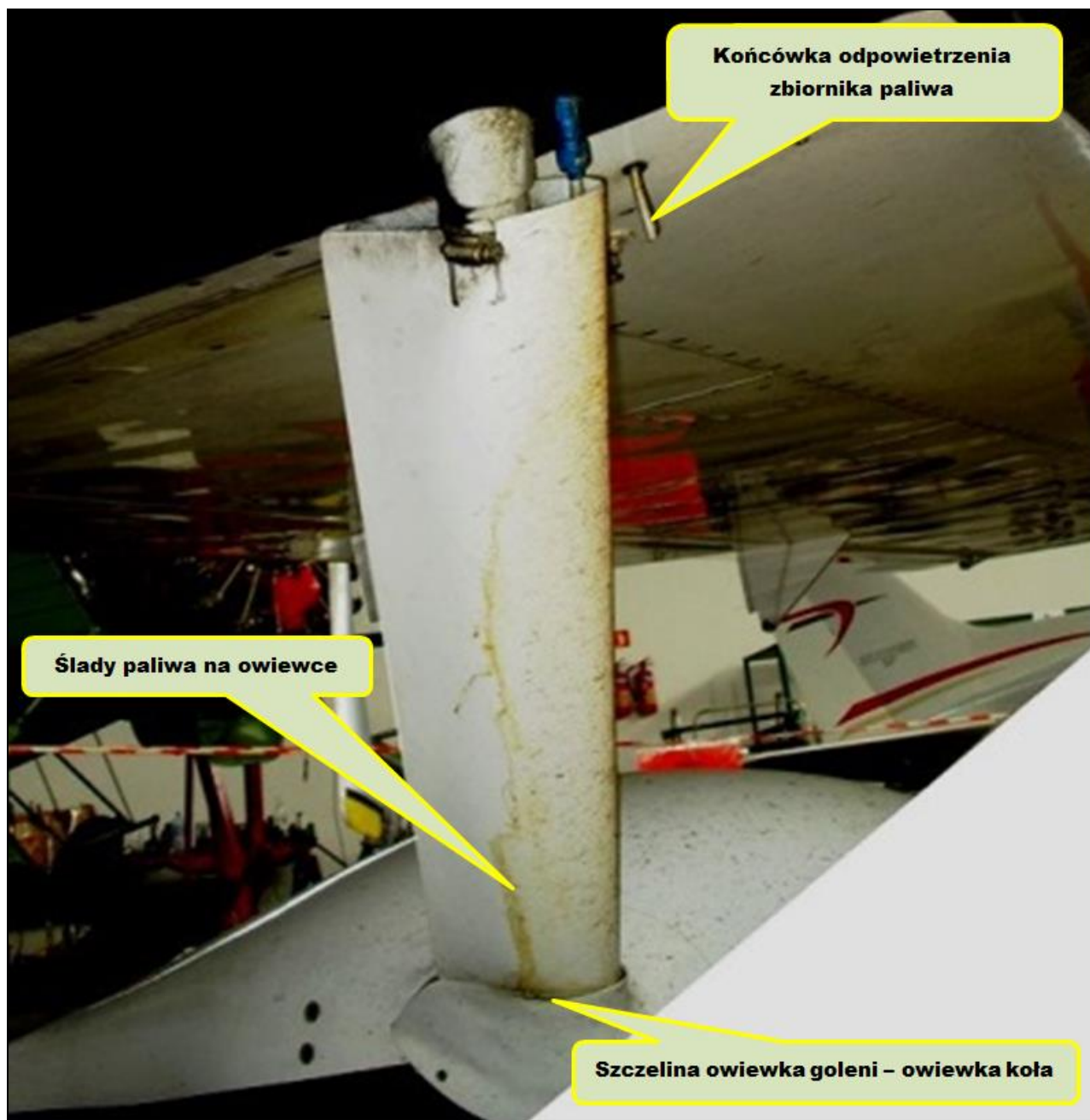
Ilustracja 8. Ślady paliwa na widoczne na lewej owiewce goleni.
