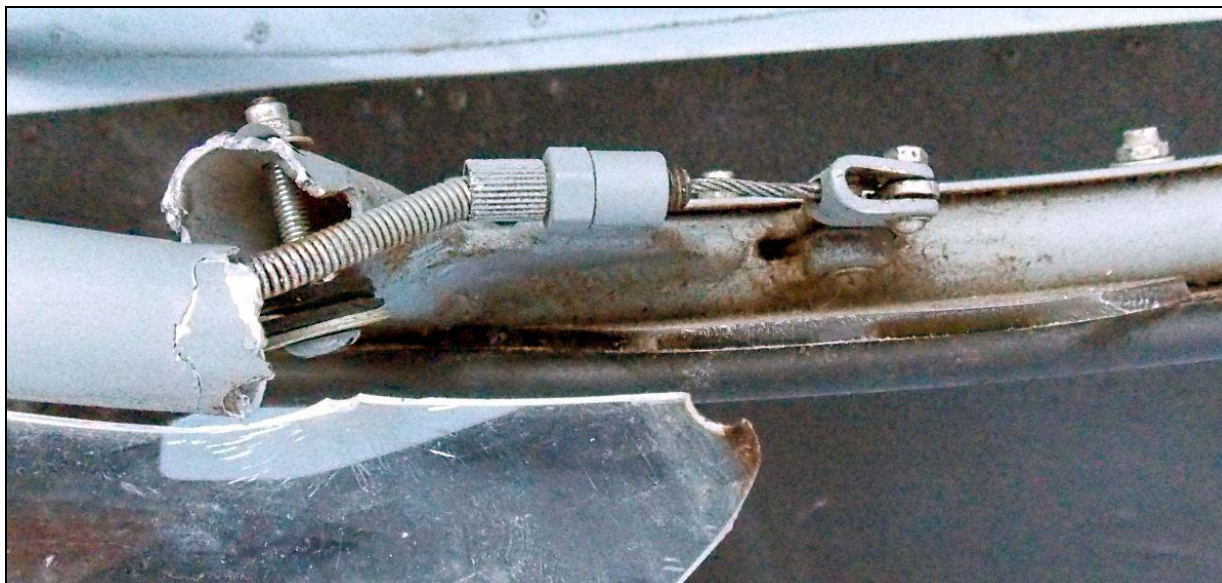
18 – Ciężno zamykania osłony kabiny przy dźwigni zamka – zachowana ciągłość połączeń.
