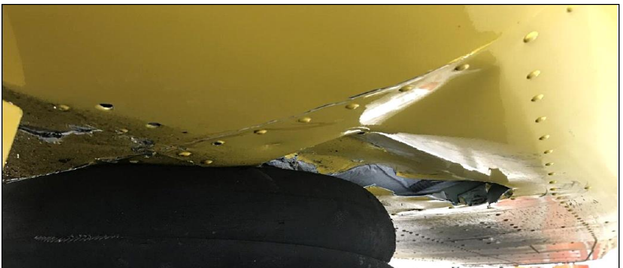
12 – Uszkodzenia dolnych pokryć kadłuba w rejonie luku przedniego podwozia [foto: Użytkownik samolotu].
