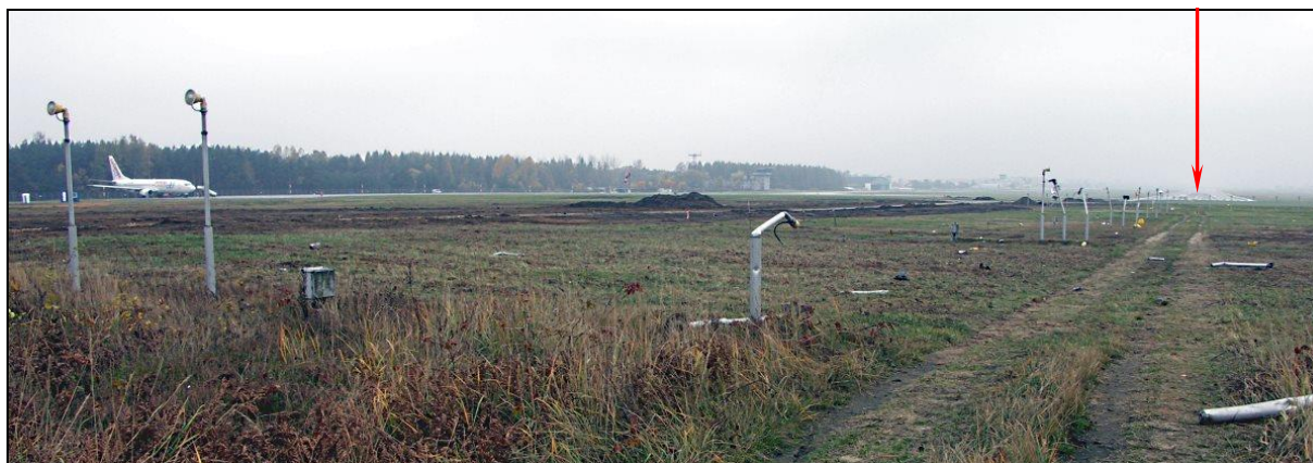
22 – Zniszczenia świateł podejścia i drobne szczątki pokrycia samolotu. Widoczny próg RWY27
