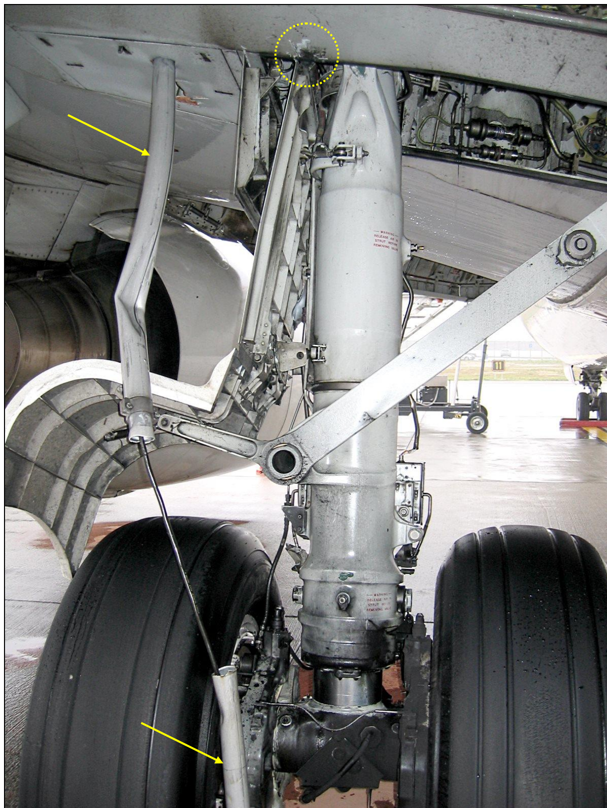
58 – Uszkodzenia pokryw lewego podwozia głównego od tyłu. Zaznaczone elementy lampy białe w konstrukcję samolotu. [foto: załoga samolotu]
