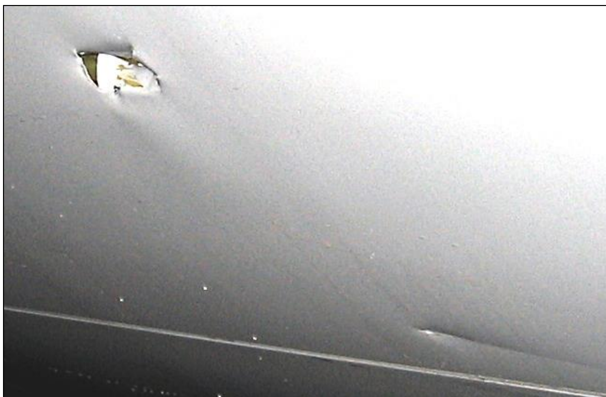
67 – Przebicie i zarysowanie kadłuba w zbliżeniu [foto: załoga samolotu]
