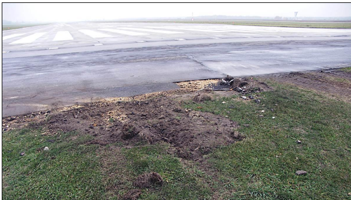
27 – Miejsce przekroczenia progu RWY27 przez koła lewego podwozia głównego samolotu
