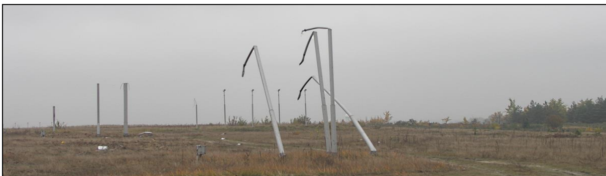
10 – Zniszczenia systemu światel podejścia przed progiem RWY27 lotniska EPKT po wypadku
