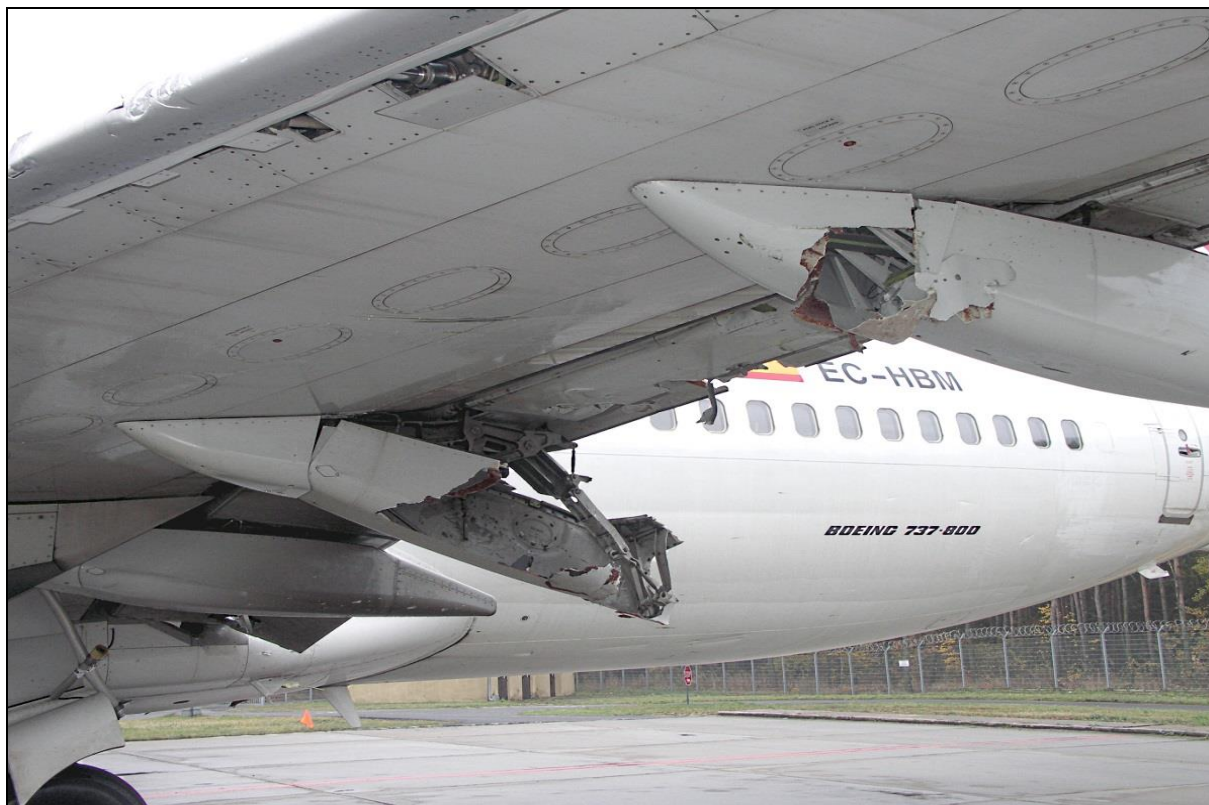
54 – Uszkodzenia kłapy i osłon prowadnic kłapy lewego skrzydła
