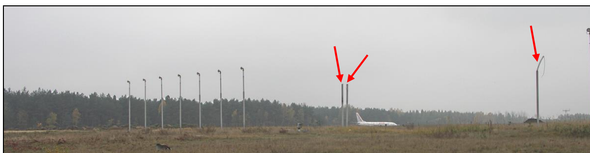
16 – Zniszczenia systemu świateł podejścia przed progiem RWY27 lotniska EPKT po wypadku
