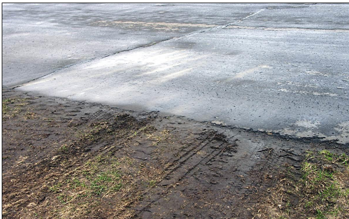
28 – Miejsce przekroczenia progu RWY27 przez koła prawego podwozia głównego samolotu
