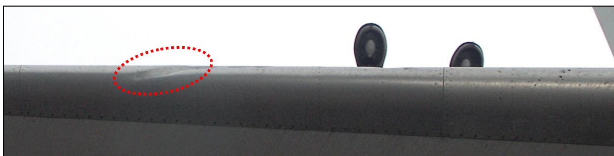
93 – Uszkodzenia noska prawego statecznika poziomego – zbliżenie
