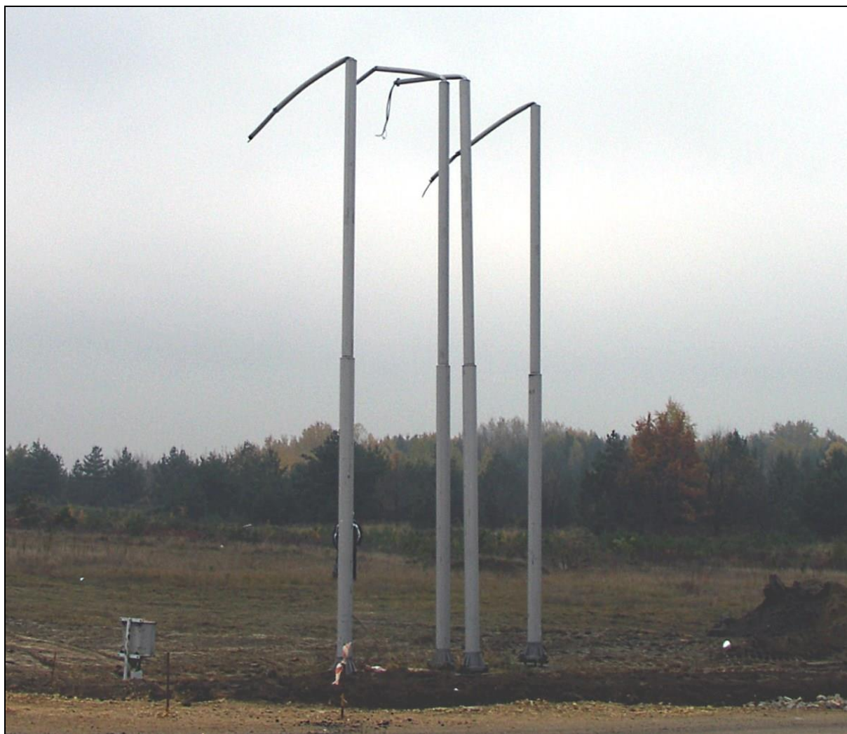
11 – Zniszczenia systemu świateł podejścia przed progiem RWY27 lotniska EPKT po wypadku
