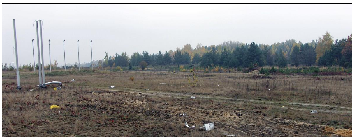
12 – Zniszczenia systemu świateł podejścia przed progiem RWY27 lotniska EPKT po wypadku
