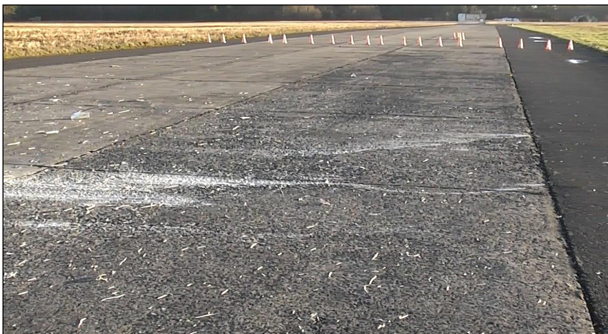
7 – Ślad pierwszego kontaktu samolotu z ziemią na granicy nawierzchni asfaltowej i betonowej drogi dojazdowej, widok w kierunku prostopadłym do kierunku lotu. [foto: KMP Koszalin]
