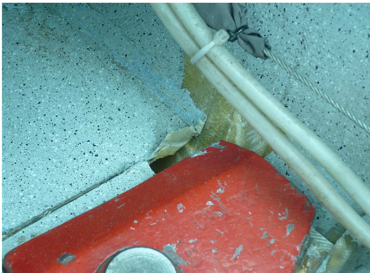
27 – Wnętrze przedniej kabiny, prawa strona. Widoczne pęknięcia i rozklejenia - zbliżenie.
