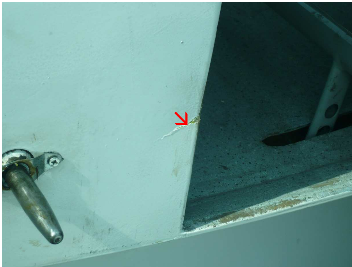
36 – Pęknięcie pokrycia kadłuba w rejonie nasady lewego skrzydła.
