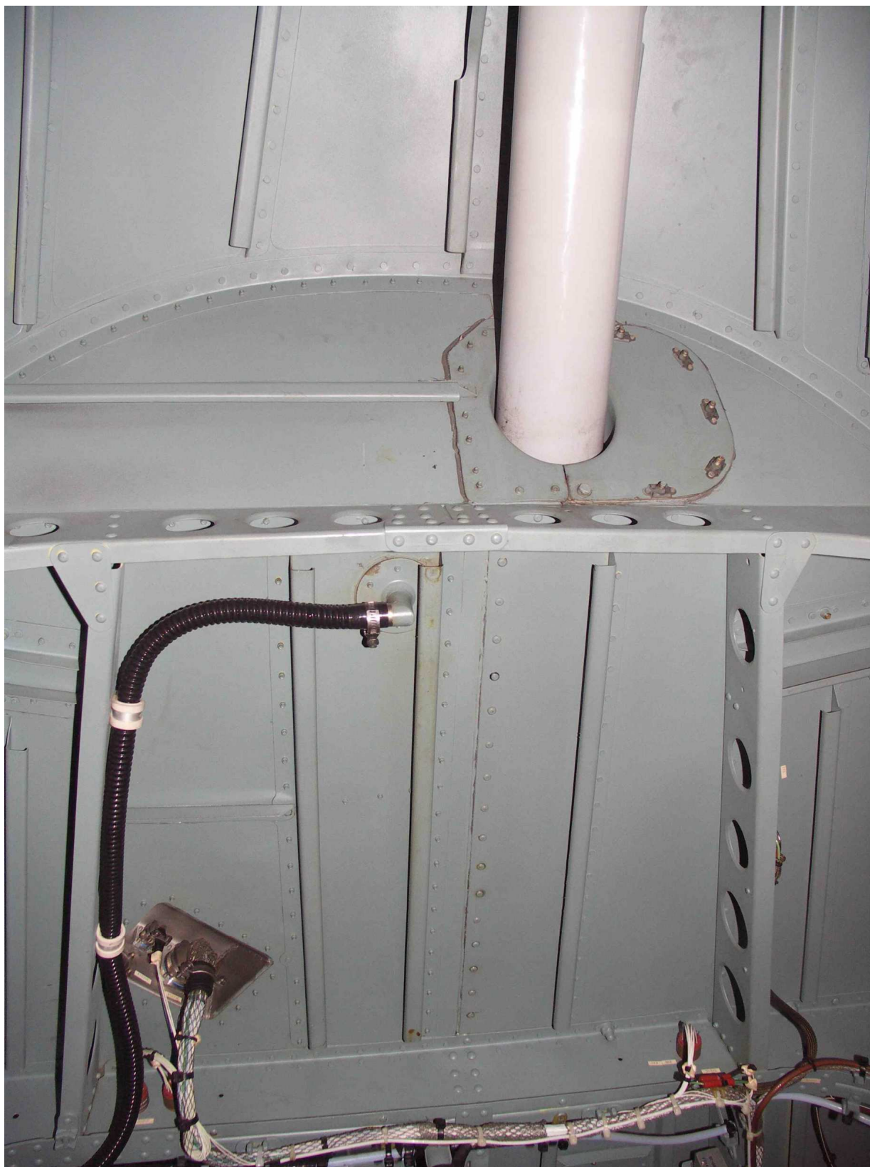
31 – Wejście wału napędowego fenestronu z belki ogonowej i kadłuba w przegrodę ogniową zespołu napędowego.
