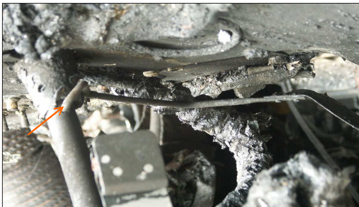
43 – Obsada lewego wolantu w tablicy przyrządów od góry – widoczna nieprawidłowo włożona blokada.
