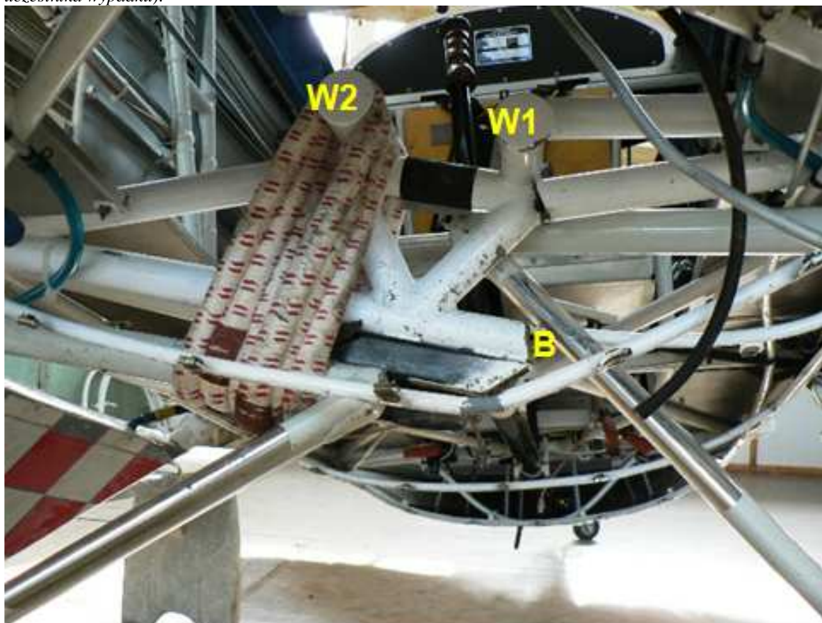
Ilustracja. 4. Widok z przodu na belkę mocowania podwozia po wypadku (zdjęcie z warsztatu remontowego dostarczone przez uczestnika wypadku).
