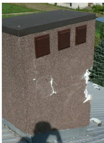
21 – Uszkodzenia komina.
