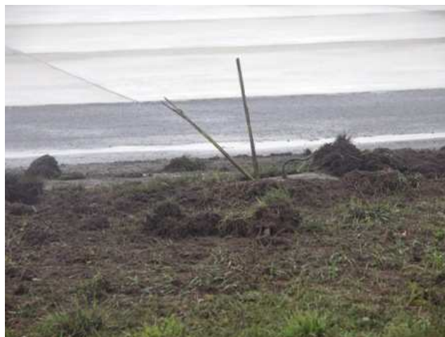
13a, b. Druga, zniszczona przez przednie podwozie, lampa krawędziowa.
