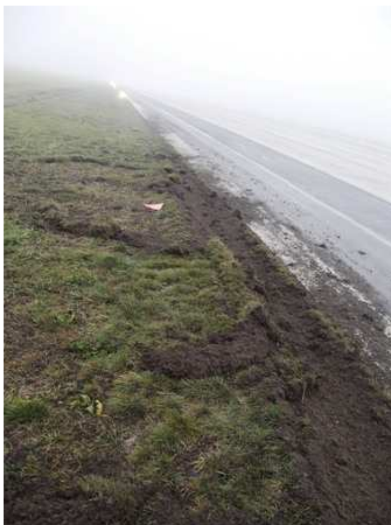
14. Ślad przedniego podwozia na krawędzi drogi startowej.
