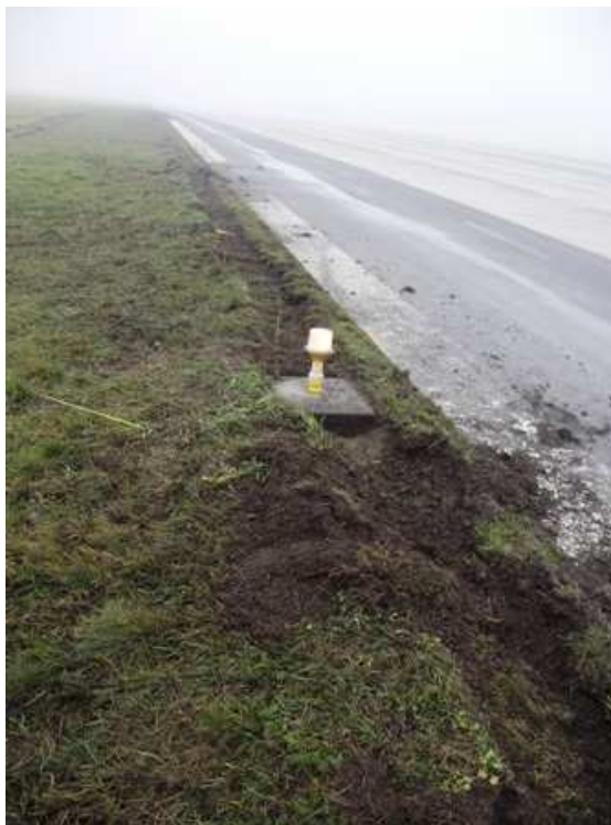
11. Lampa krawędziowa (na zdjęciu po naprawie) uszkodzona przez samolot; prawdopodobnie o fundament tej lampy została uszkodzona wewnętrzna krawędź felgi prawego koła podwozia przedniego.
