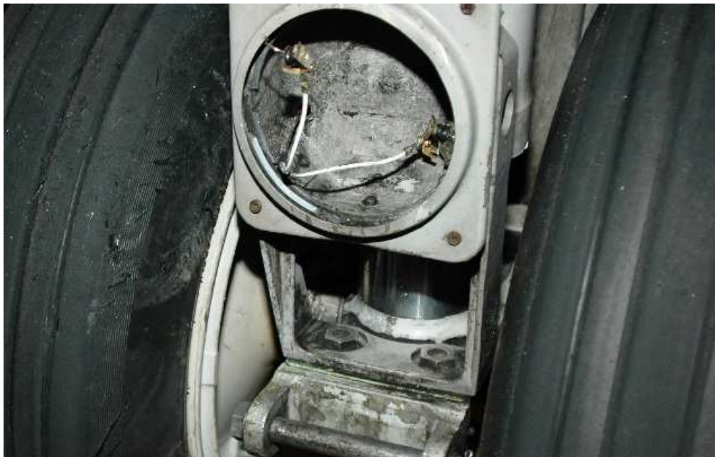
38. Zdjęcie reflektora kołowania wykonane na samolocie w po lądowaniu w WAW. Wyraźnie widoczne uszkodzenia, których nie można nie zauważyć przy przedlotowym przeglądzie samolotu.
