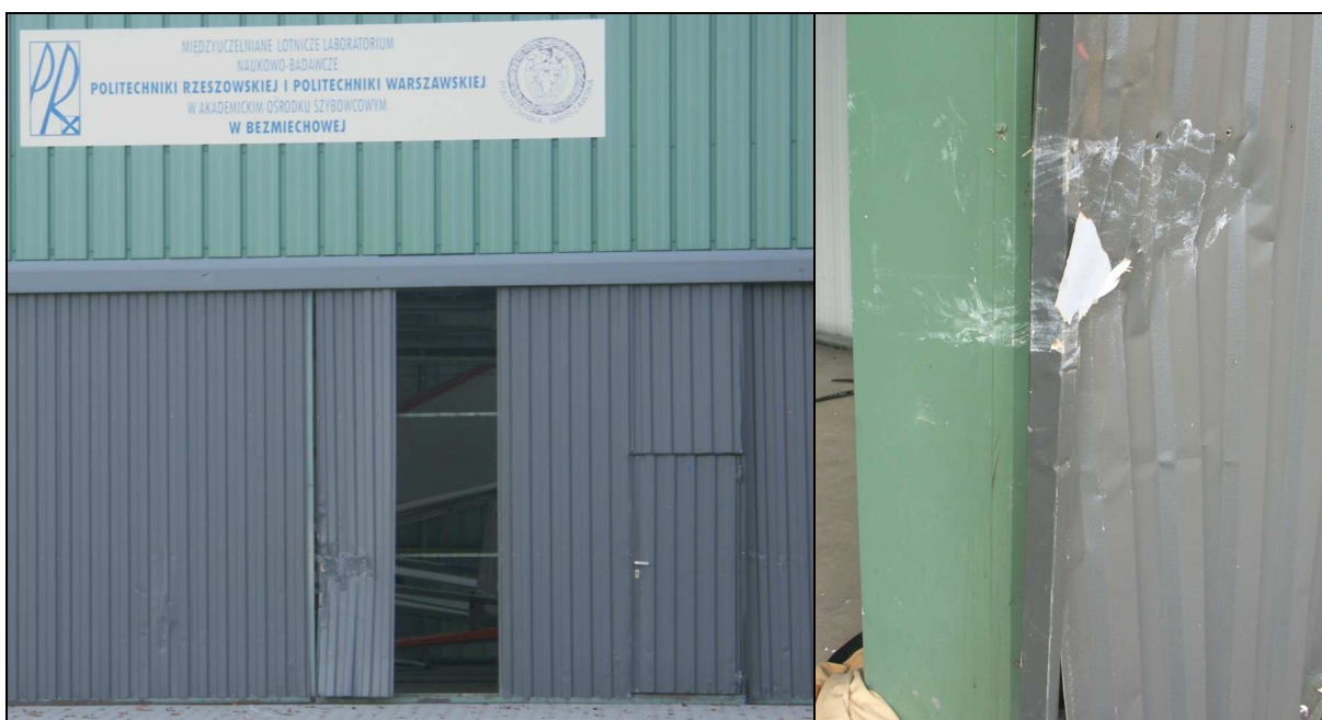
69, 70 – Ogólny widok uszkodzonych wrót hangaru (zamkniętych) i zbliżenie na ślad kolizji szybowca, widoczny na ramie i obrzeżu wrót.
