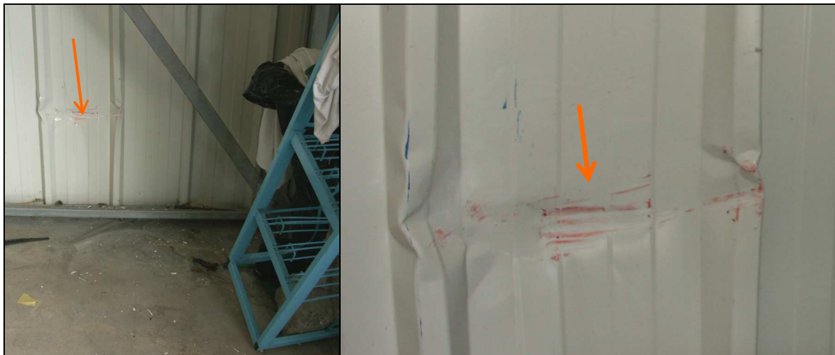
71, 72 – Ślady kolizji (poprzecznego otarcia) noska kadłuba szybowca ze ścianką wewnątrz hangaru. Widoczny metalowy niebieski regał, który pozostawił ślady otarcia na prawej burcie kabiny.
