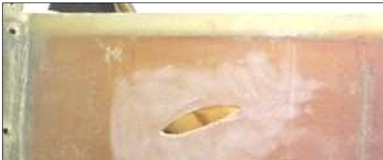
36 – wykrój wykonany w płaszczu zbiornika paliwowego.
