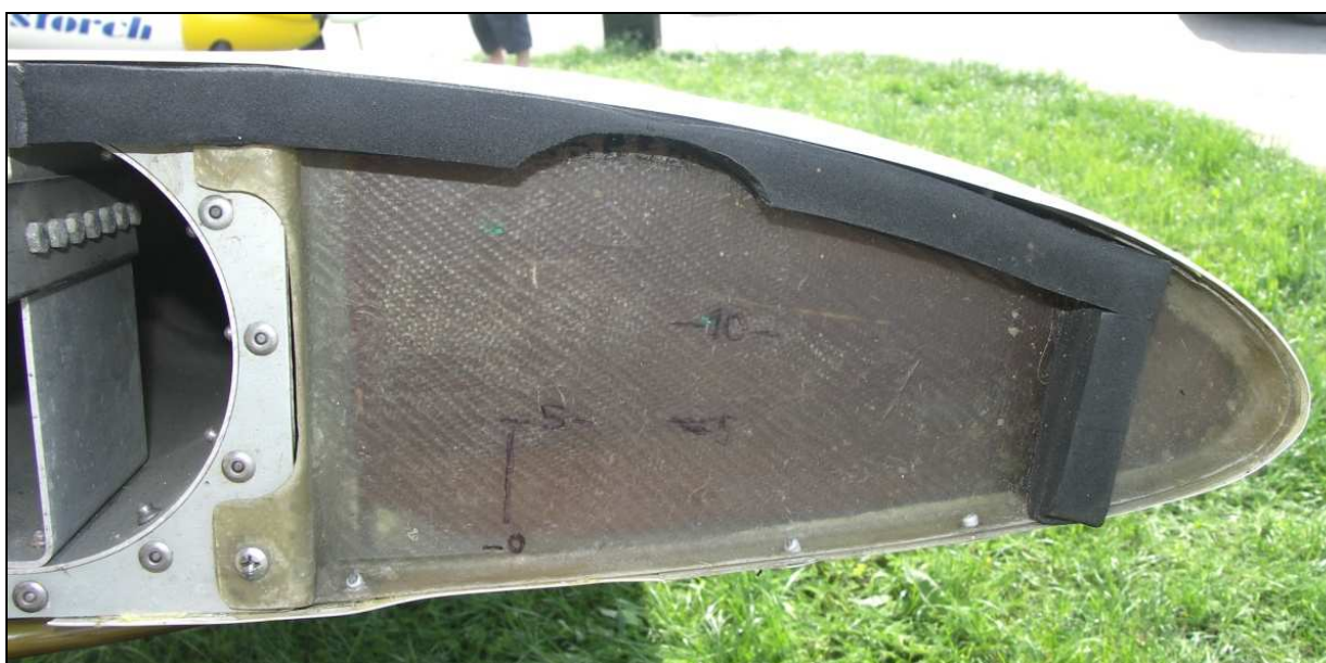
34 – Żebro nasadowe lewego skrzydła – widoczny półprzezroczysty zbiornik paliwowy z naniesioną prowizorycznie skalą..
