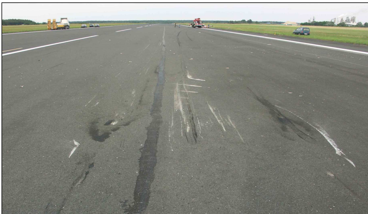
5 – Ślady przyziemiaenia. Dalej widoczne rozsypane drobne szczątki łopat śmigła oraz odłamki obręczy koła przedniego podwozia.
