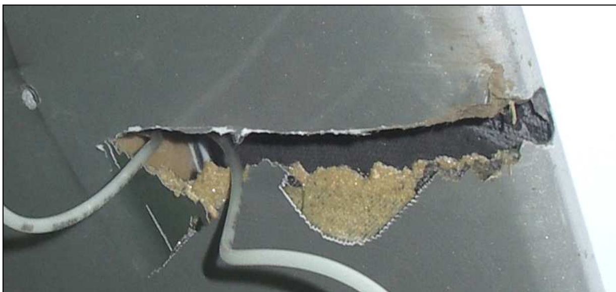
14 – Zbliżenie uszkodzeń końcówki prawego skrzydła – rurki Pitota brak.
