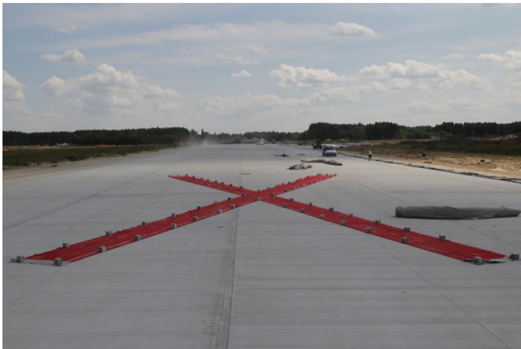
Fot. 15. Oznaczenie zamkniętej drogi startowej w rejonie progu THR 27.
