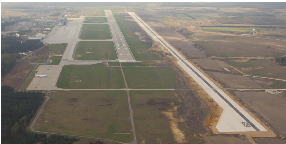
Fot. 2. Lotnisko Katowice-Pyrzowice (11.04.2014), kierunek 27 – z prawej strony budowana droga startowa. [zdjęcie EPKT]. W dniu zdarzenia nie było już czarnego pasa wzdłuż na nawierzchni drogi startowej.
