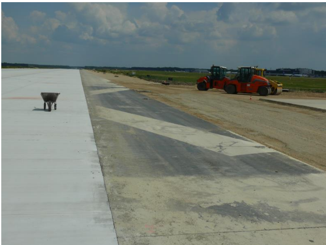
Fot. 5. Zabetonowane pozostałości oznakowania zamkniętej drogi startowej przy progu THR 09.
