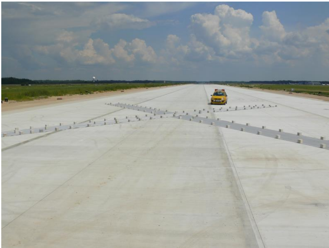
Fot. 4. Oznaczenie zamkniętej drogi startowej przy progu THR 09.
