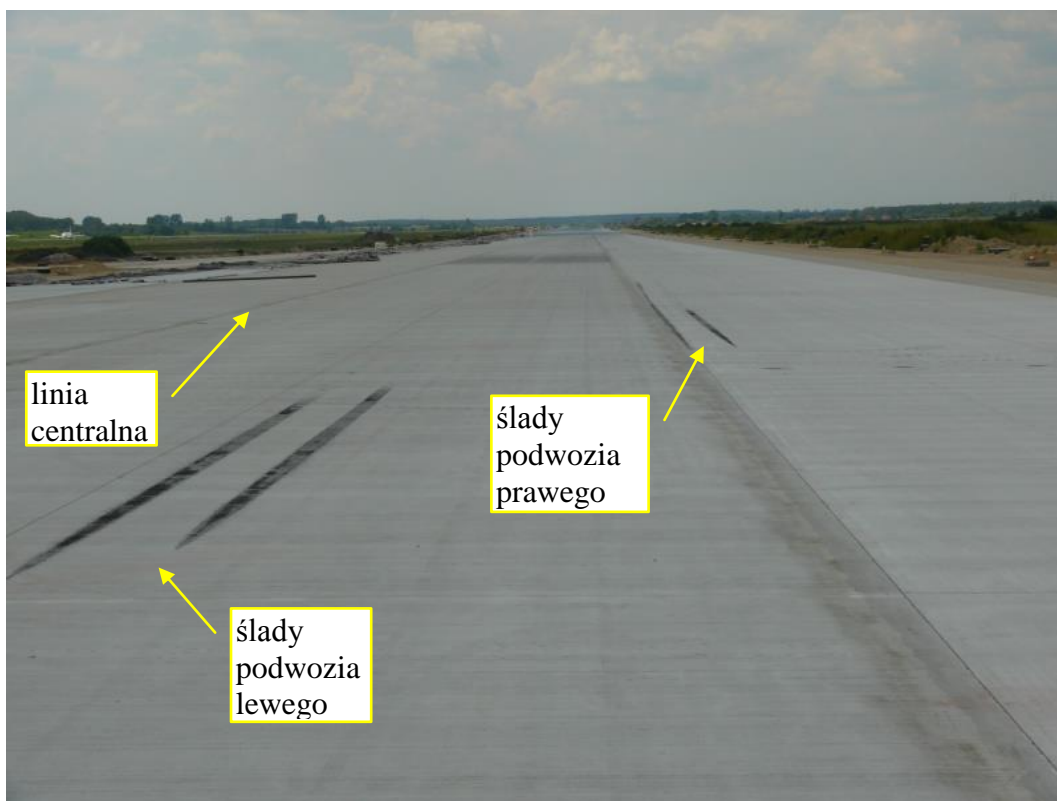
Fot. 7. Ślady przyziemienia samolotu Bombardier CRJ-700 (~870[m] od początku nawierzchni 27).
