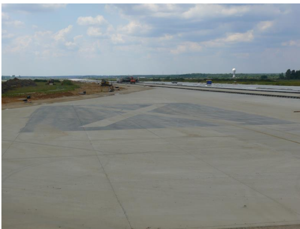
Fot. 3. Oznaczenie zamkniętej drogi startowej przy progu THR 27.
