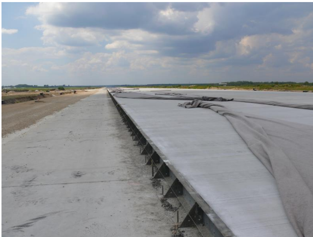
Fot. 11. Konstrukcja formująco/ograniczająca nawierzchnię budowanej drogi startowej (lewa strona).
