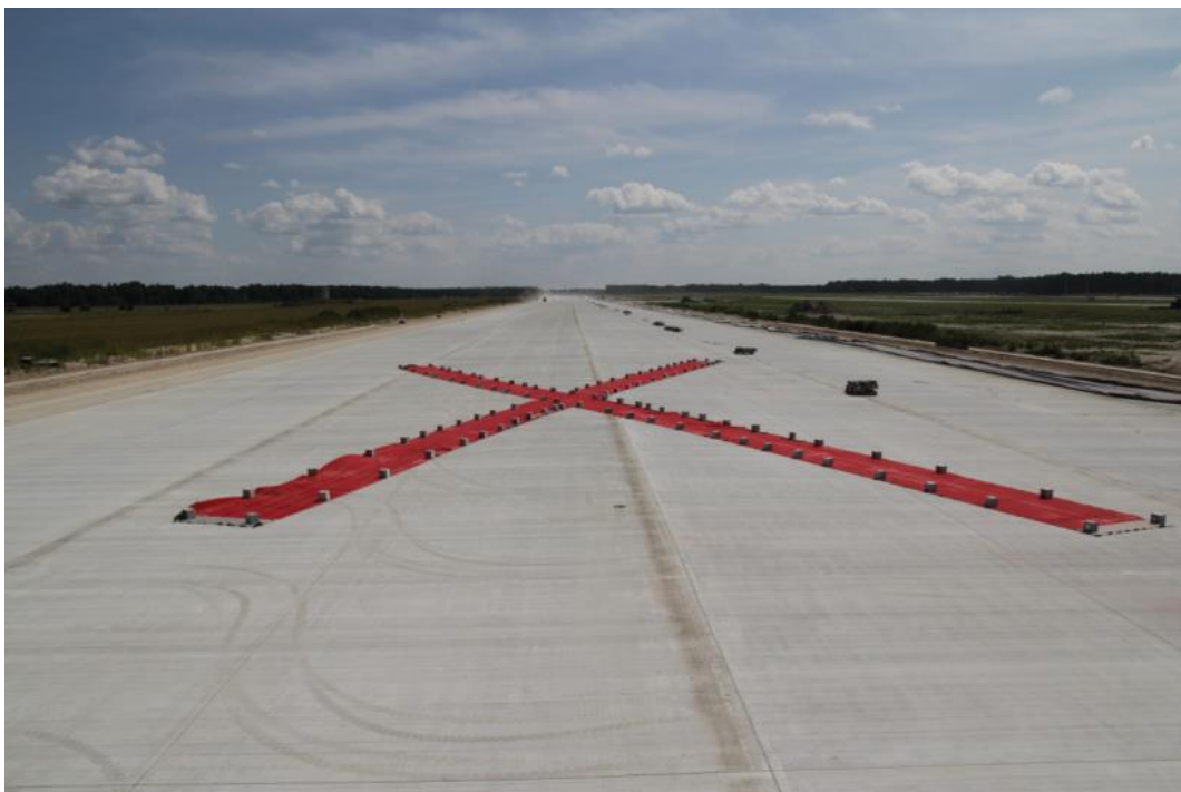
Fot. 17. Oznaczenie na środku zamkniętej drogi startowej.
