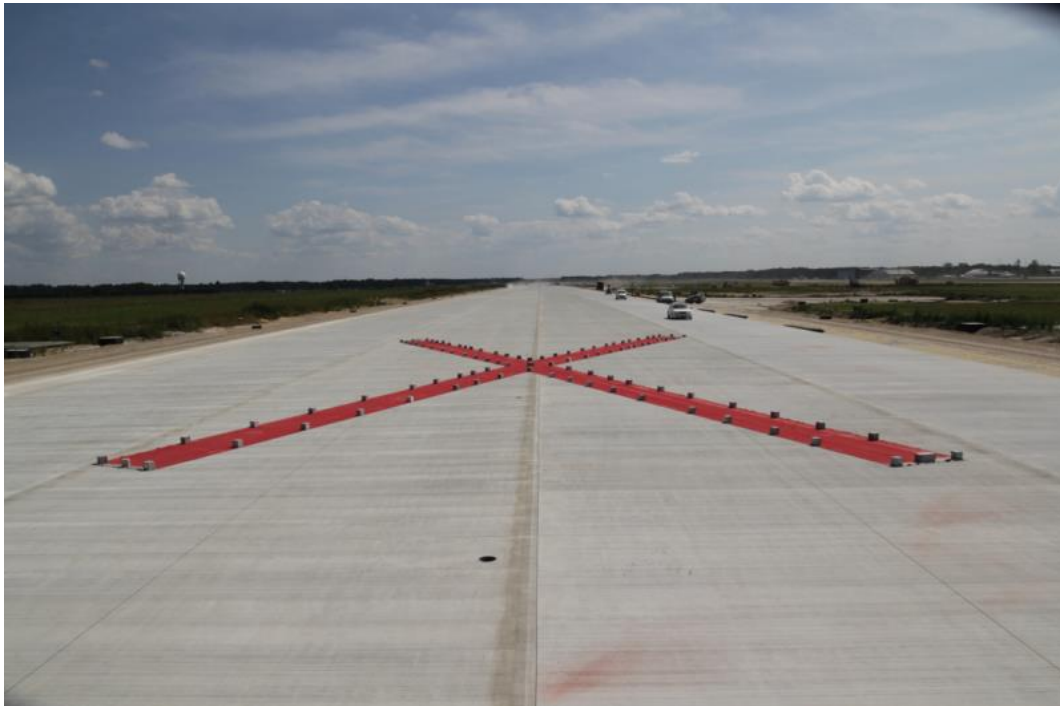
Fot. 16. Oznaczenie zamkniętej drogi startowej w rejonie progu THR 09.
