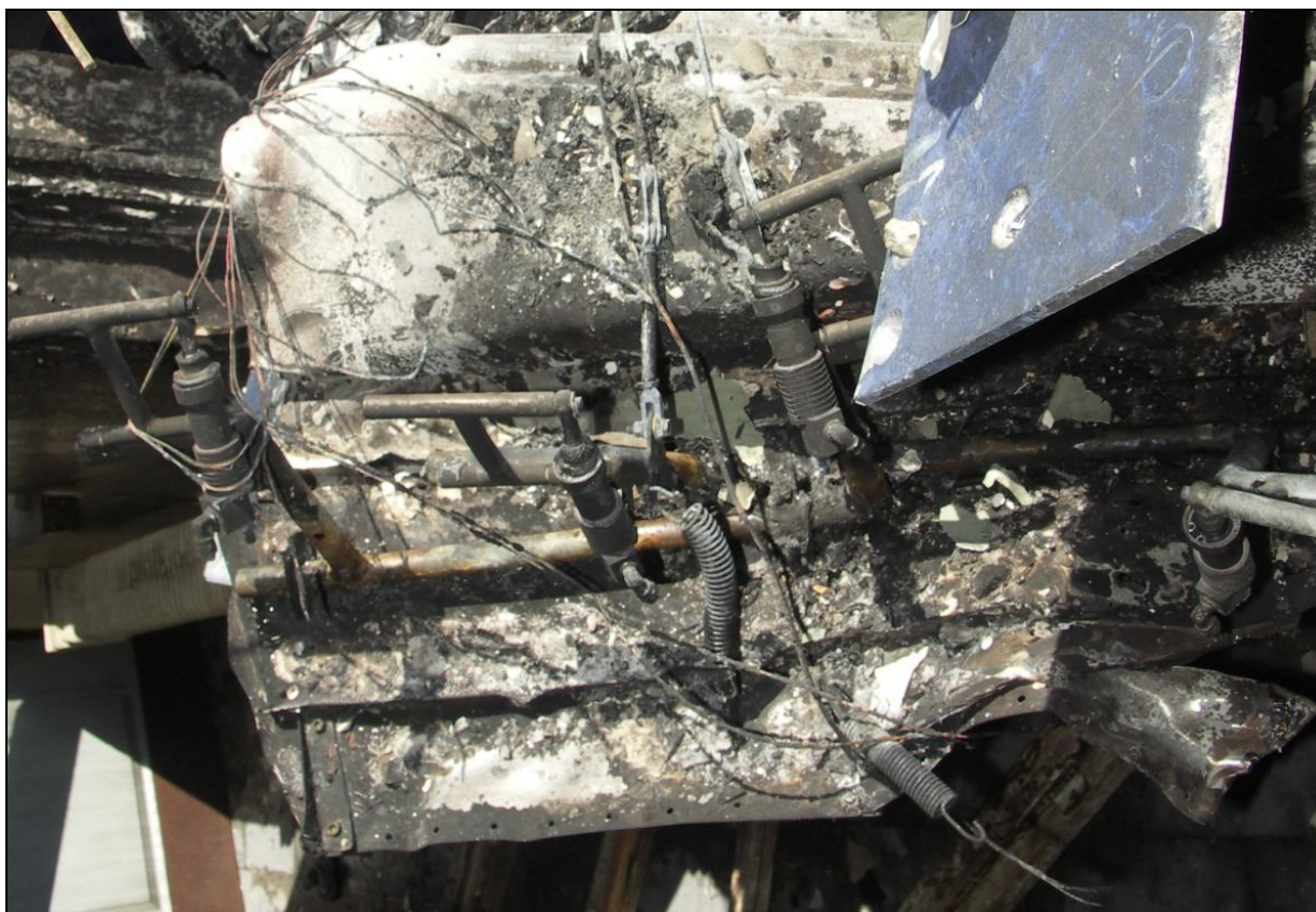
19 – Szczątki ściany ogniowej ze sterownicami nożnymi na parapecie okna, w które uderzył samolot – zbliżenie.
