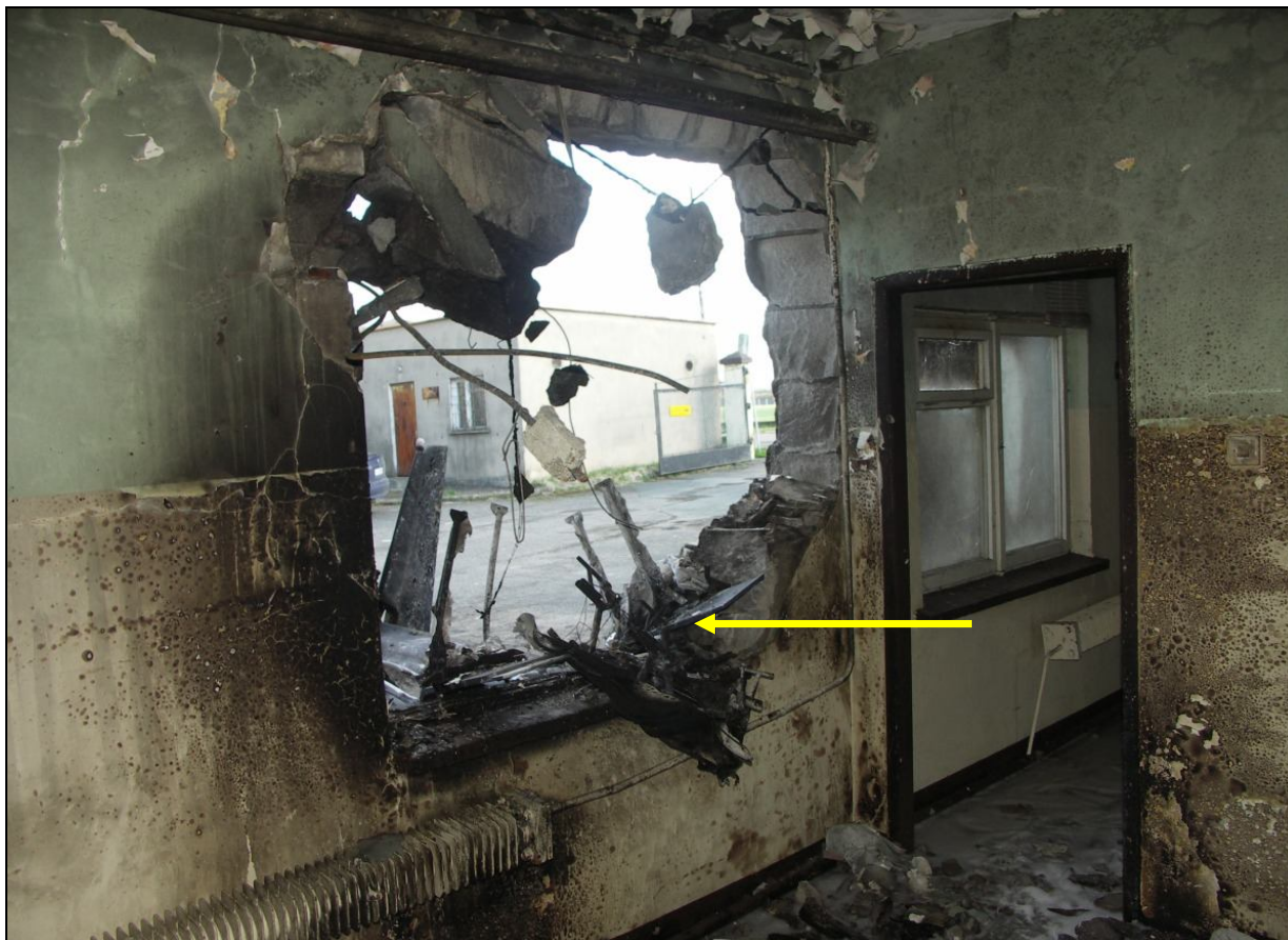
18 – Wnętrze pomieszczenia budynku, w którego okno uderzył samolot. Na parapecie widoczne szczątki ściany ogniowej ze sterownicami nożnymi, wskazane strzałką.
