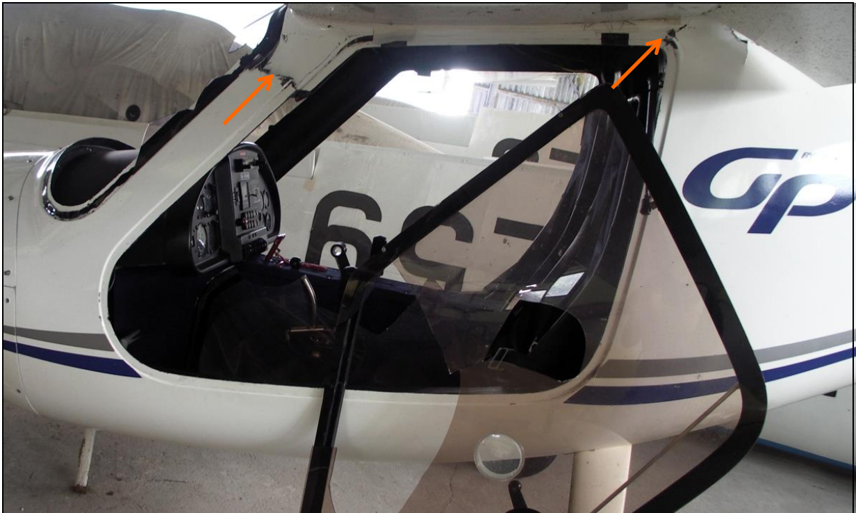
29 – Lewa strona kabinowej części kadłuba. Widoczne zniszczenia struktury kadłuba – popękane wręgi (strzałki pomarańczowe).
