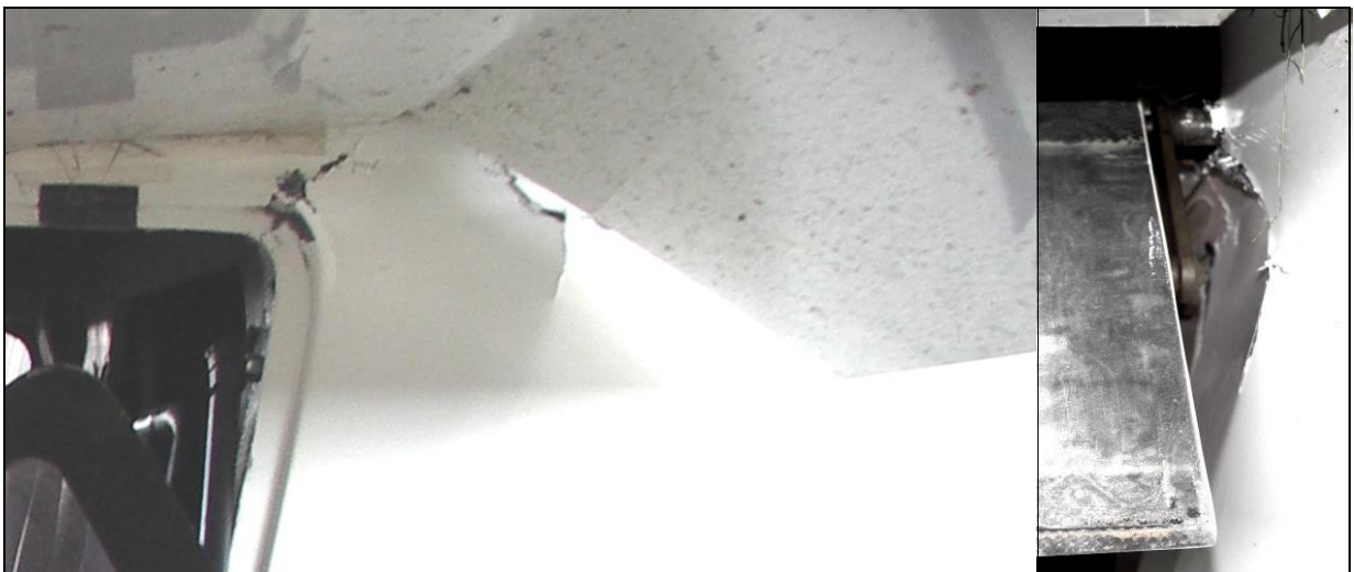
32 – Uszkodzenia przy górnym tylnym narożu lewych drzwi kabiny. Ich charakter może świadczyć o uszkodzeniu tylnej wręgi kabiny w tym rejonie. Widoczna wychylona kłapa lewego skrzydła.
