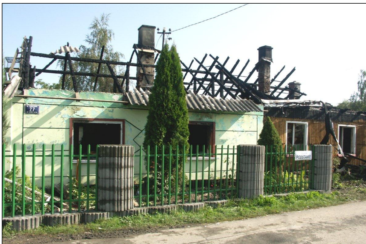
40 – Domy przy ul.Podstawie 27 i 27a następnego dnia po wypadku – widok od strony południowo-zachodniej
