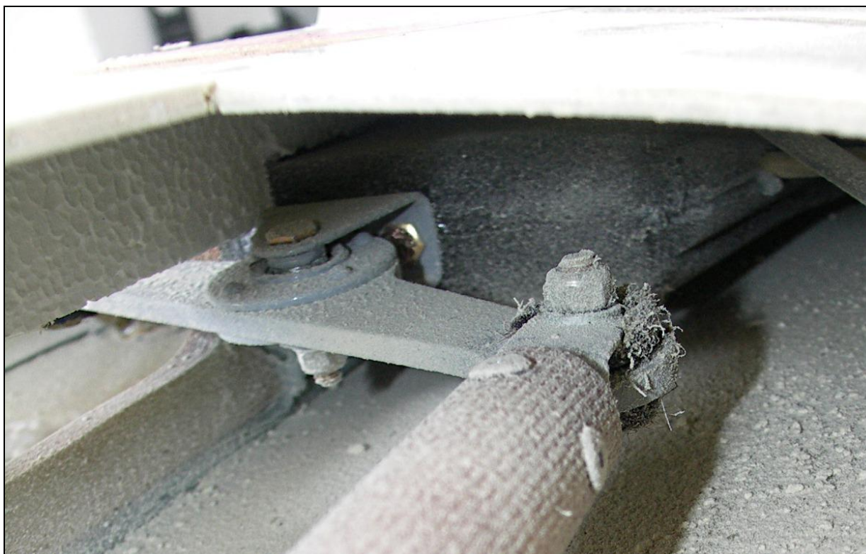
19 – Zbliżenie na tę samą dźwignię układu sterowania sterem wysokości z drugiej strony dźwigara statecznika pionowego. Widoczna końcówka kompozytowego pionowego popychacza umieszczonego w stateczniku.
