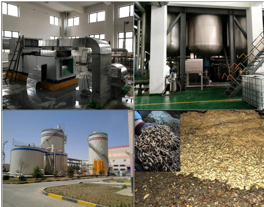
Ryc. 16 Zautomatyzowany zakład przetwarzania odpadów z łańcucha rolno - spożywczego na bazie hodowli Hermetia illucens (mucha czarna) w prefekturze Baotou (Chiny), gdzie jest utylizowane ponad 100 ton odpadów organicznych dziennie, wykorzystywanych do produkcji biogazu oraz białka owadów o masie około 1,3 tony dziennie (źródło: EVO Conversion Systems, LLC).
